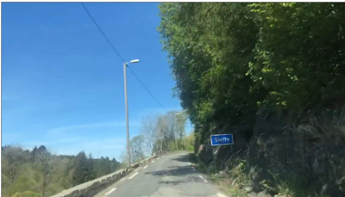
Bilete 14: Smal veg med krapp kurvatur ved Mellingen. Det er skjeringar og betongmur der det er liten eller ingen plass på utsida av kvitstripa på fv. 411 Hellandsvegen, fartsgrense 50 km/t. Vurdert som særleg farleg/vanskeleg strekning for alle elevar.
