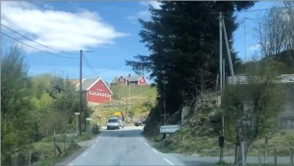
Bilete 19: Kryss fv. 409 Rossnesvegen x fv 409 Radøyvegen, fartsgrense 50 km/t. Dårlig sikt og smal vegskulder medfører at krysset er definert som særleg farleg/vanskeleg skuleveg.
