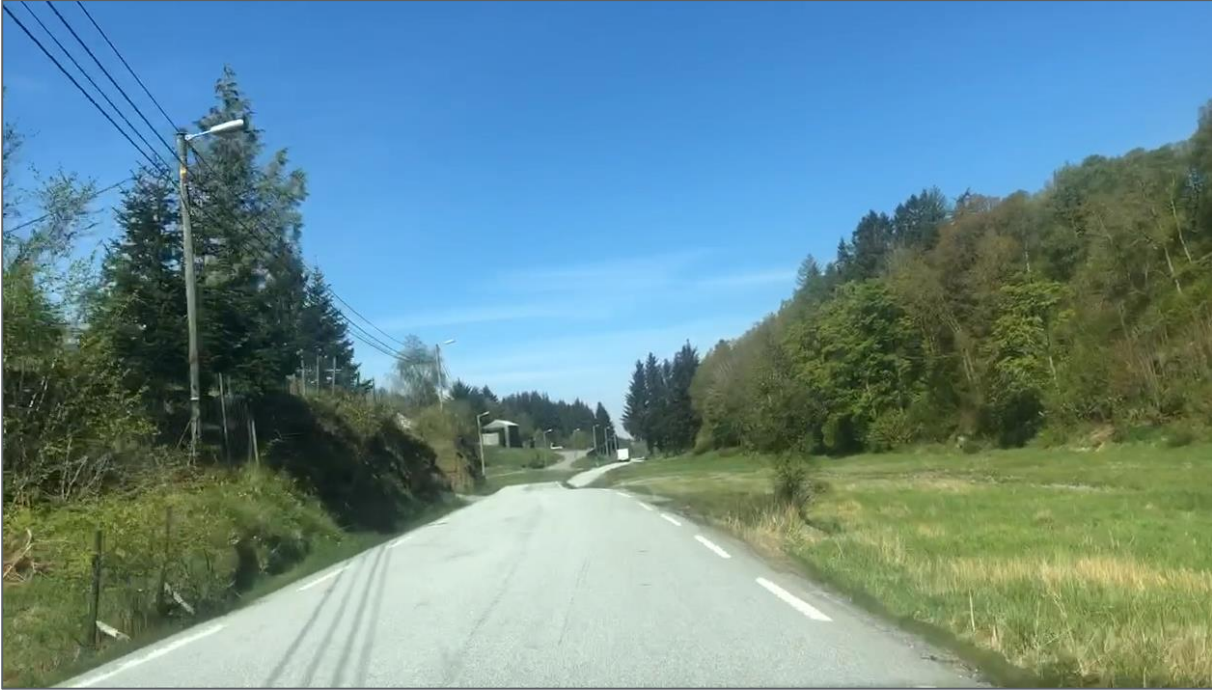
Bilete 12: Bilete frå strekninga nord-enda av Gjeldsvatnet til nordenda av Klessvatnet på fv. 565 Slettevegen, fartsgrense 60 km/t. Vurdert som særleg farleg/vanskeleg strekning for 1. og 2. klasse.
