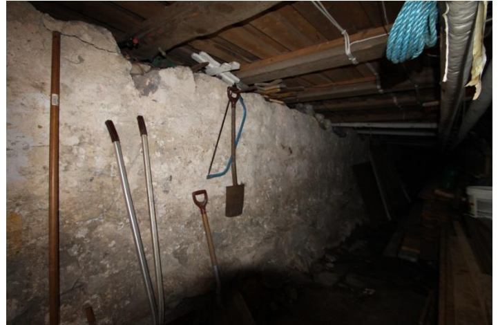
Figur 2. Grunnmur sett fra innsiden (østre langvegg).
