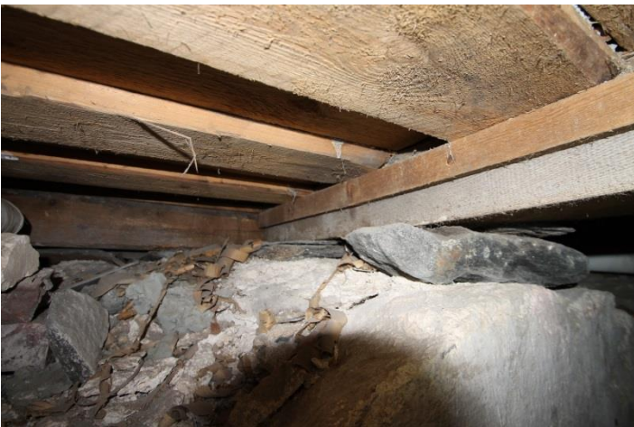
Figur 3. Bærekonstruksjon fundamentert på bruddstein
