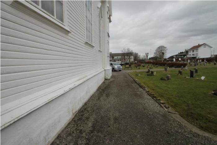
Figur 1. Grunnmur sett fra utsiden (østre langvegg)
