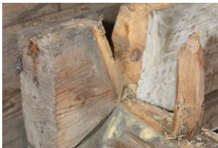
Figur 10 Eksempel på dømling i lafteverk
