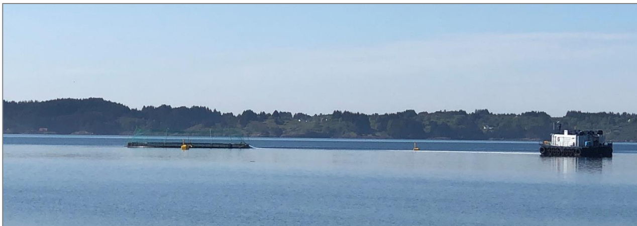
Figur 25. Bilde av dagens anlegg på Toska Sør. Bildet er teke i retning mot Meland kommune.
