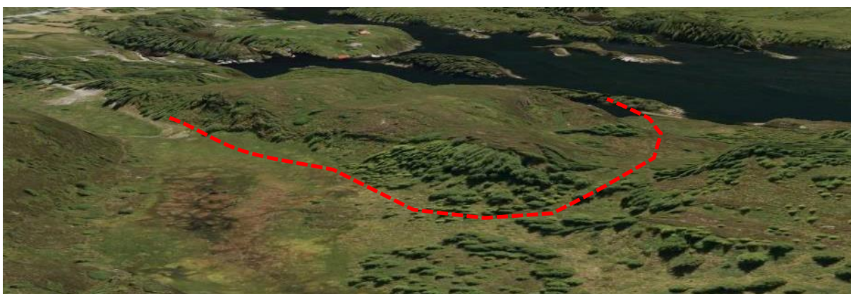
Figur 18: Eksisterende veg og planlagd vegtrasé sett frå nord
