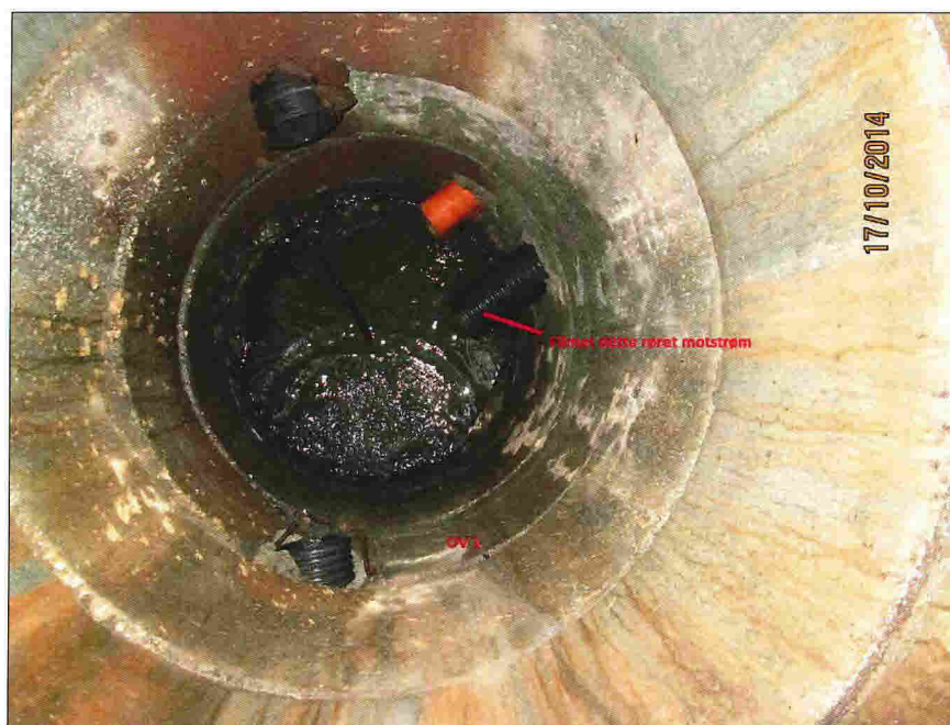
Foto: OV 1.JPG 0m, Start inspeksjon -
