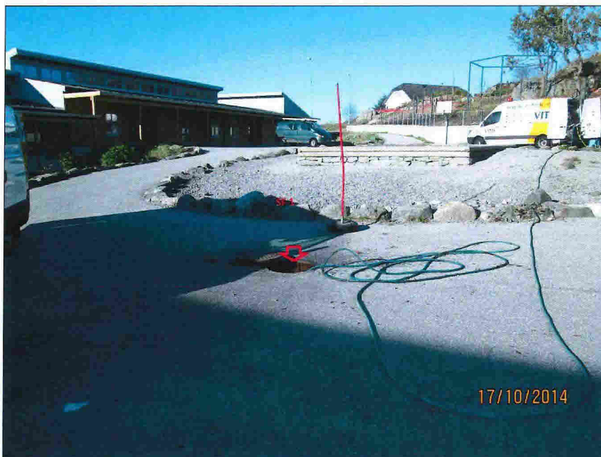
Foto: Oversikt SF 1.JPG 0m, Start inspeksjon -
