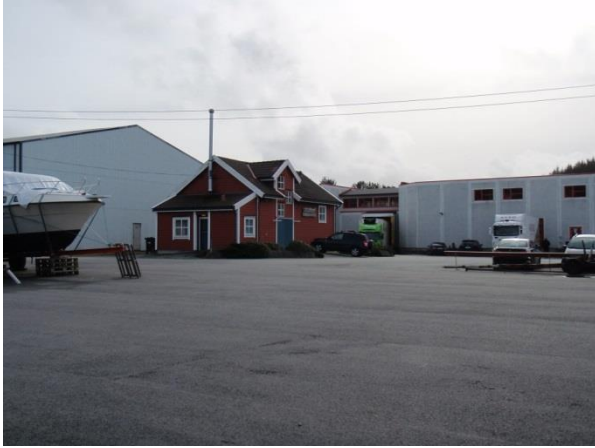
Kommunalt anlegg for avløp på kaien i Bøvågen.
