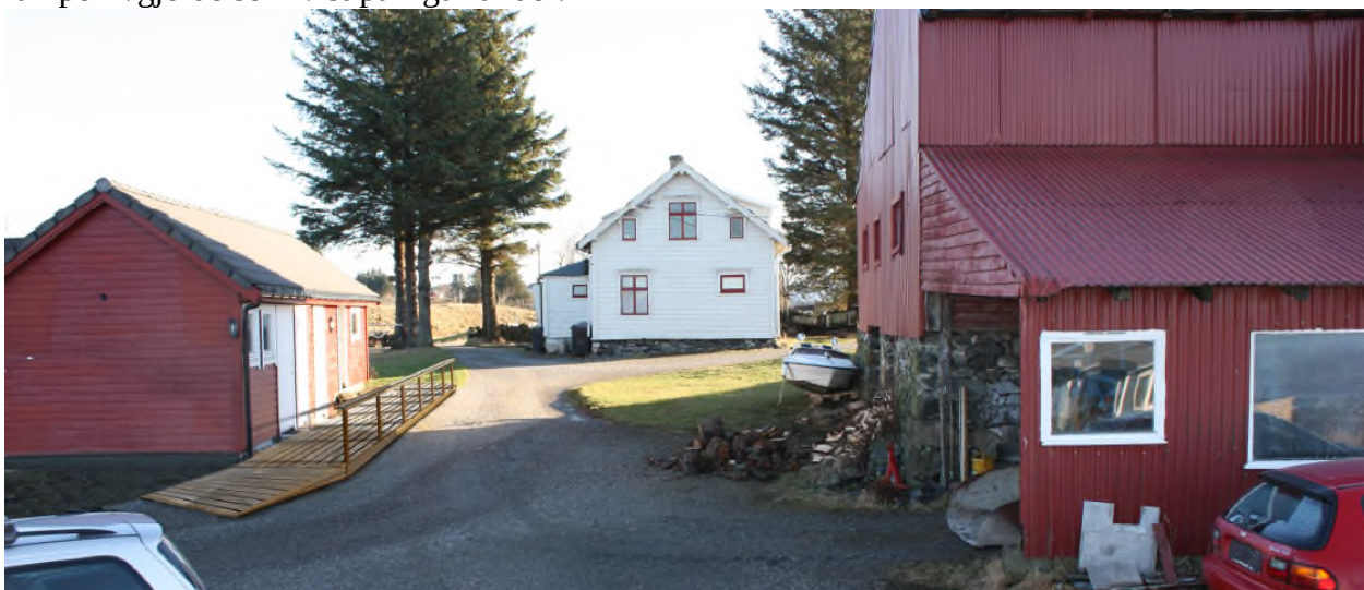
Figur 28 Fotomontasje, Sanitæranlegg til venstre i bilete.
