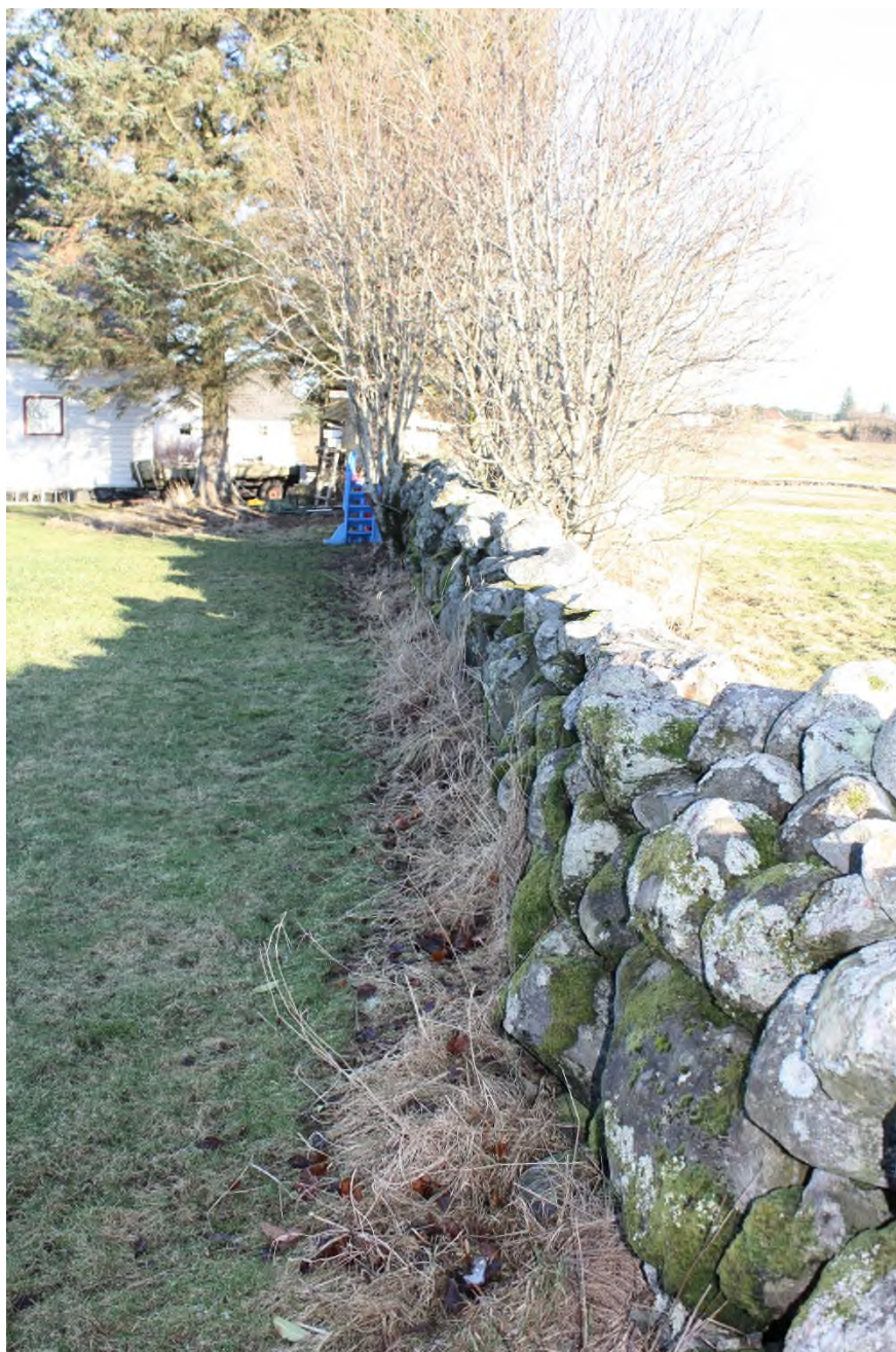
Figur 22 Steingard langs sørleg planavgrensing
