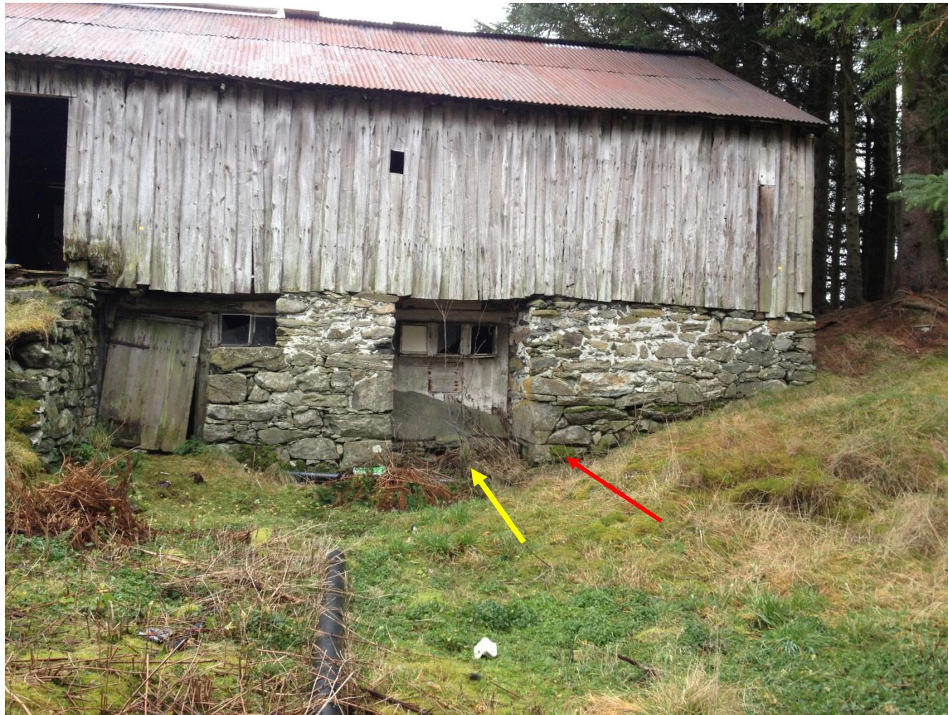
Pila peiker på skade i murvangen på Låvebrua (merkt med 4 på skissa)
