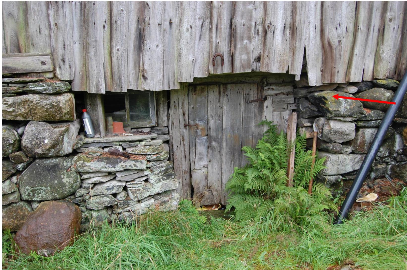
Austveggen. Ved døra ved vernemuren heilt i sør. Utrasing i innervangen har også skipla steinar i yttervangen. Her må eit parti av grunnmuren takast heilt ned, fundamentert på nytt og reisast opp att. Under arbeidet må bygningen stemplast av med dekkestøtte eller liknande. Dersom det er trøng for heving/avretting av trekonstruksjonen kan det gjerast i same omgang.
