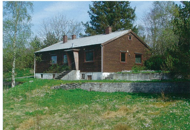
Huset i Lerøy fort friluftsområde var i dårlig stand og ble revet i 2014.
