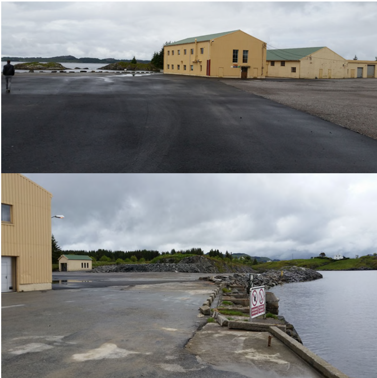
Figur 7 Situasjon på planområde i dag med kaiområde og eksisterende bygg.
