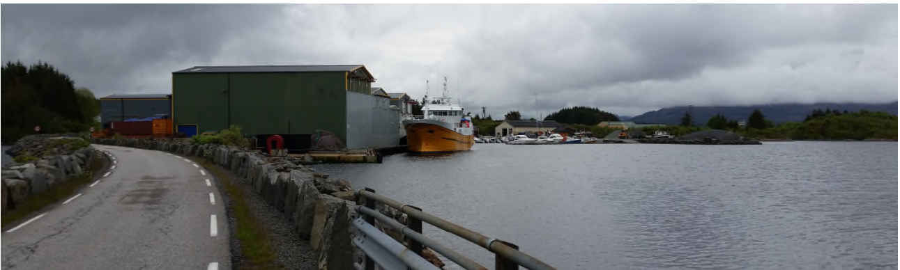
Figur 41 Sett frå nordvest, vegen mot Toska, med og utan bygg lagt inn.
