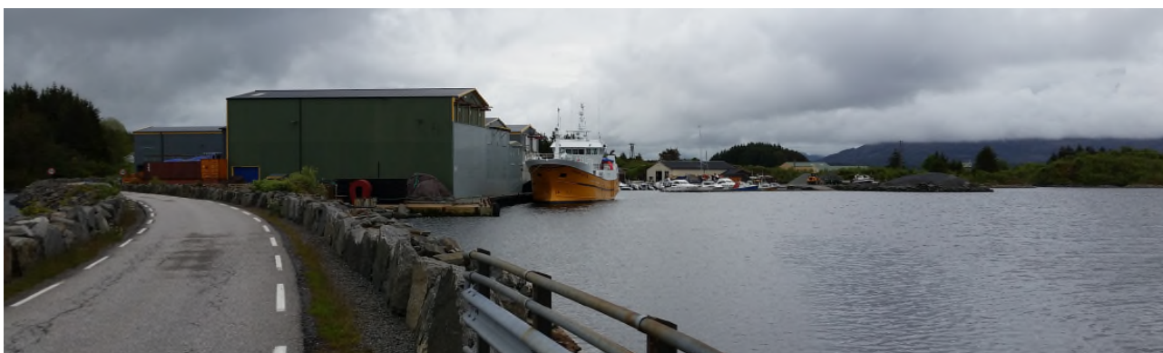
Figur 41 Sett frå nordvest, vegen mot Toska, med og utan bygg lagt inn.
