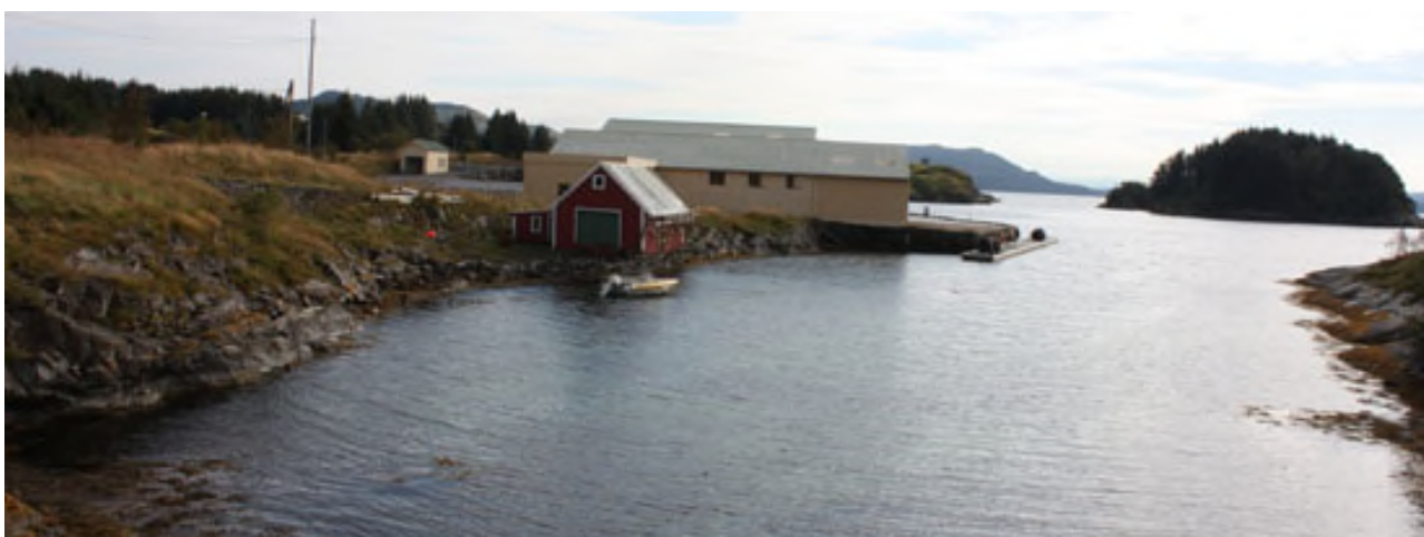
Figur 9 Sett inst frå vika mot eksisterande naust og bygg i planområdet.
