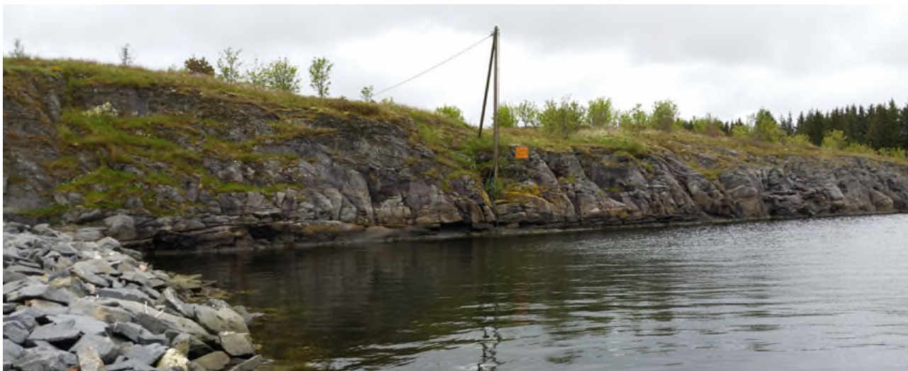
Figur 8 Sørøstleg del med sprengsteinsfylling og bratt strandlinje
