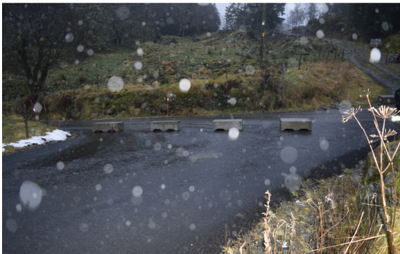
Foto fra gårdsvei mot sør/FV412 Grindheimsvegen
