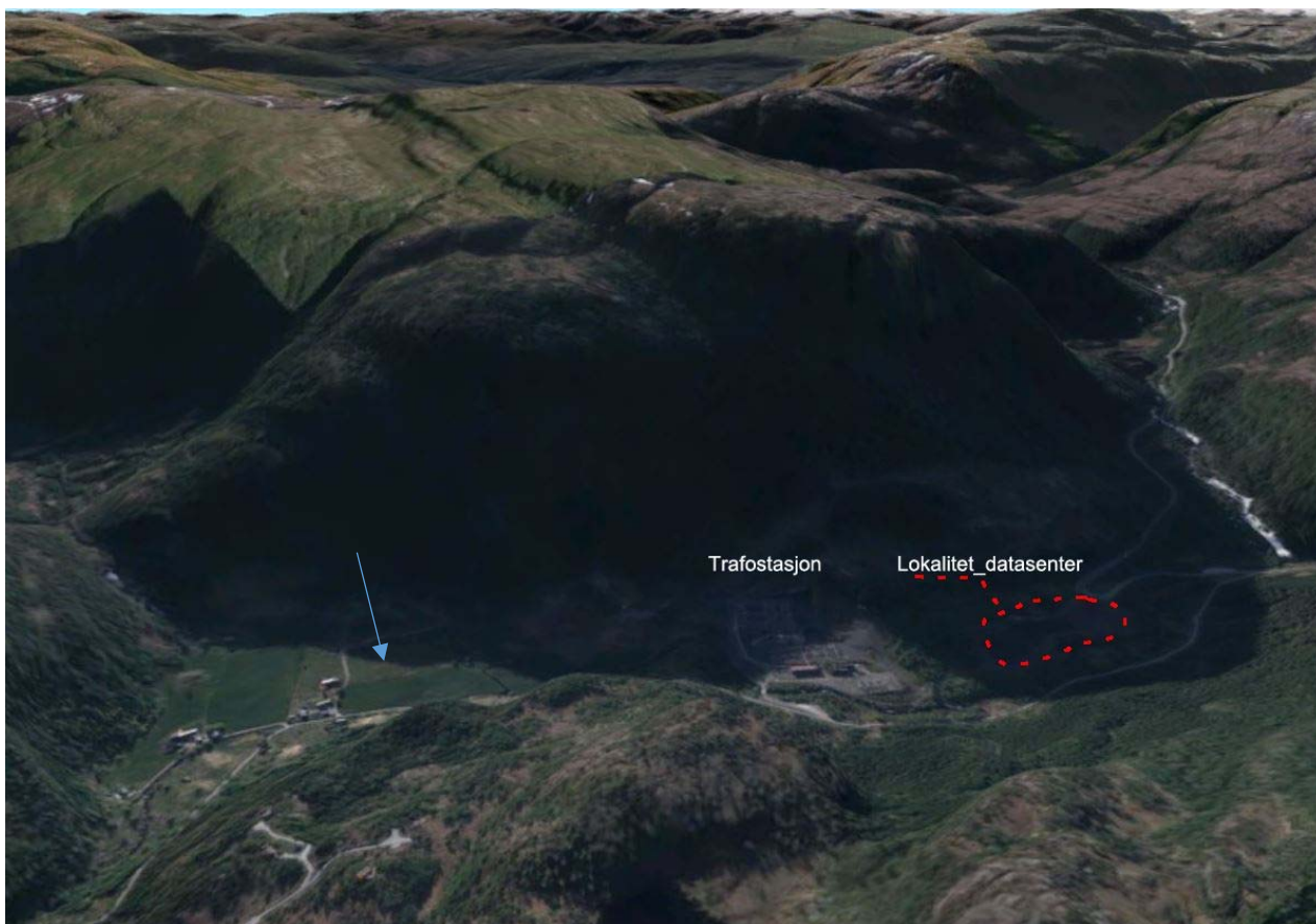
Figur 12 - Dei store, samanhengande landbruksflatane sør for trafostasjonen ( blå pil)er eit karakteristisk og sårbart landskapselement
