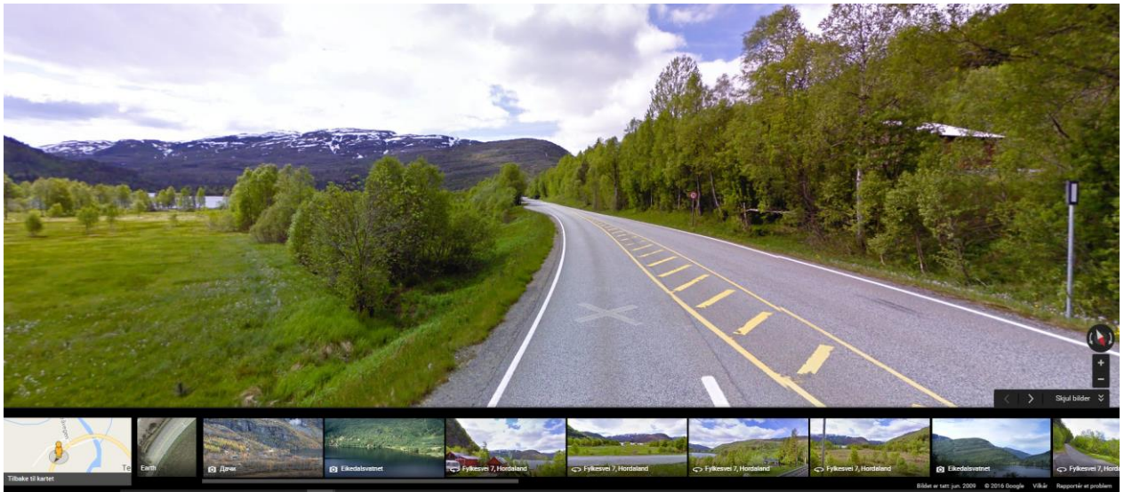
Fig. 5.10.c: Foto av området når du køyrer mot Bergen, kelde: streetview
