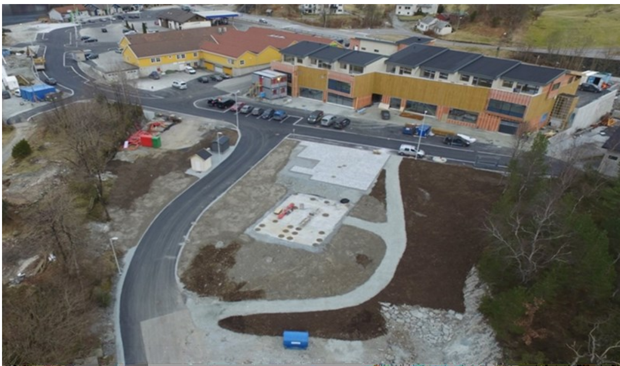
Bjørkheim –VA-anlegget, park og bibliotek – Foto Hylland
