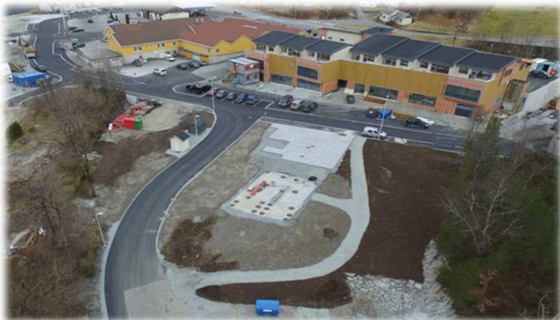
Bjørkheim –Veg, VA-anlegget, park og bibliotek – Foto Hylland
