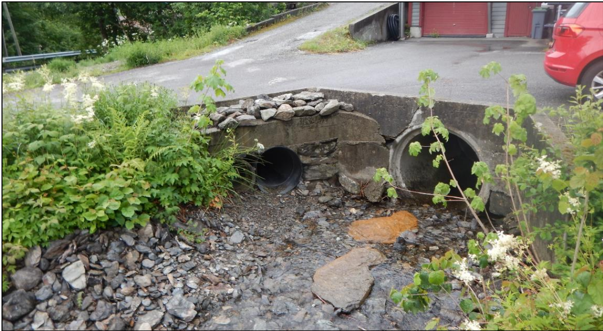
Figur 11: Bilde av kulvertinntak ved punkt 3.
