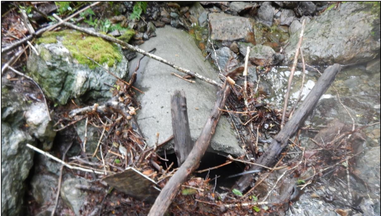
Figur 10: Bilde av kulvertinntaket ved punkt 1.
