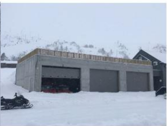
Garasje med takterrasse – sett frå parkeringsplassen
