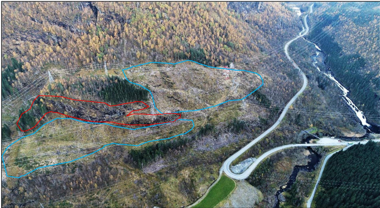
Figur 2: Hogstfelt under kraftlinjene, som gir potensielle løснеområder for snøskred (i blått). Fjellskrenten som kan gi steinsprang mot tiltaksområdet, er også vist (i rødt).
