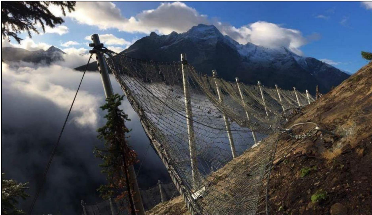
Figur 5: Eksempel på støtteforbygning i løснеområde for snøskred ( www.geobrugg.com ).
