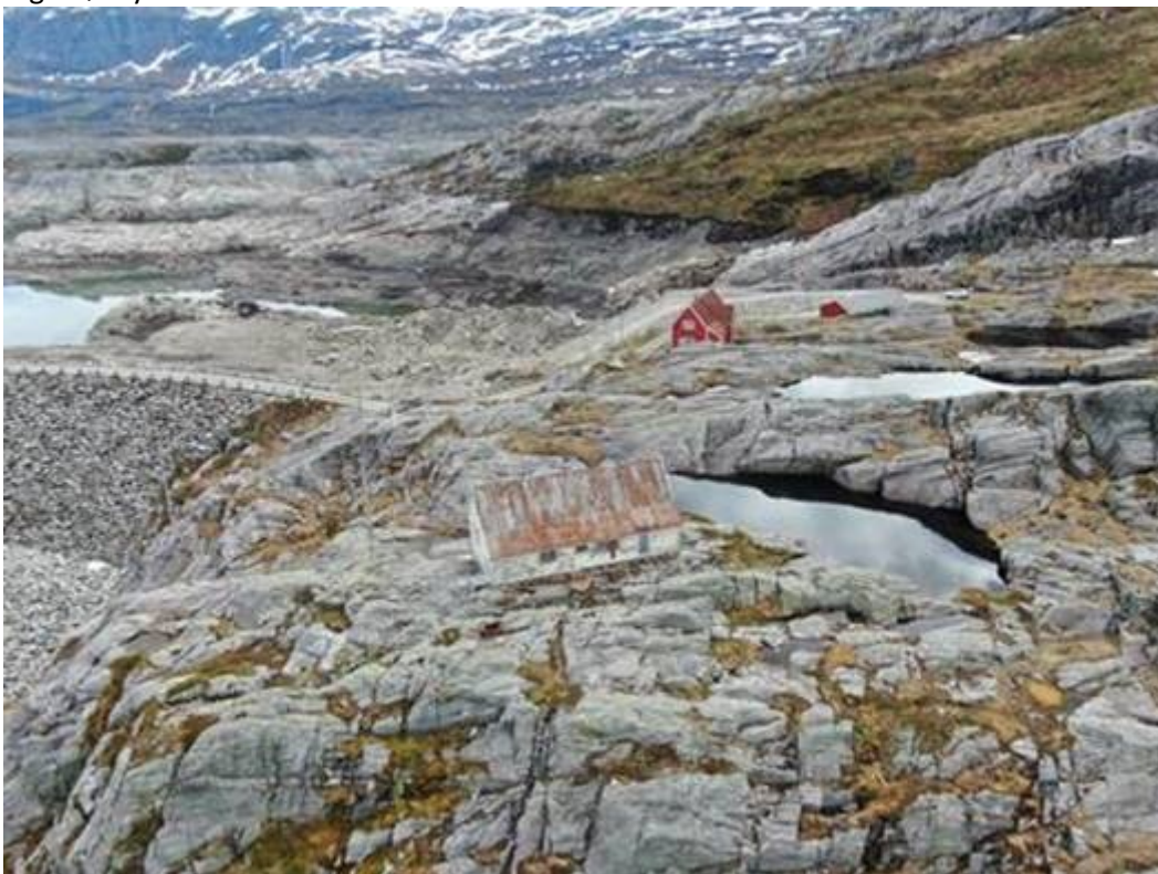
Minikraftanlegget ved Svartavatnet
