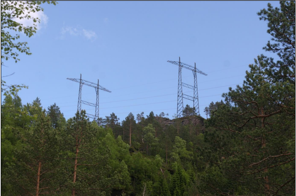
Fig. 37. Montering av mastene til 420 kV linjen Sima – Samnanger pågikk våren 2011. Her 2 master på høydedrag sør for Storeli den 11. juni 2011. Mastene er godt synlig fra Rv 7 mot Kvamskogen. Foto: A. Håland©
