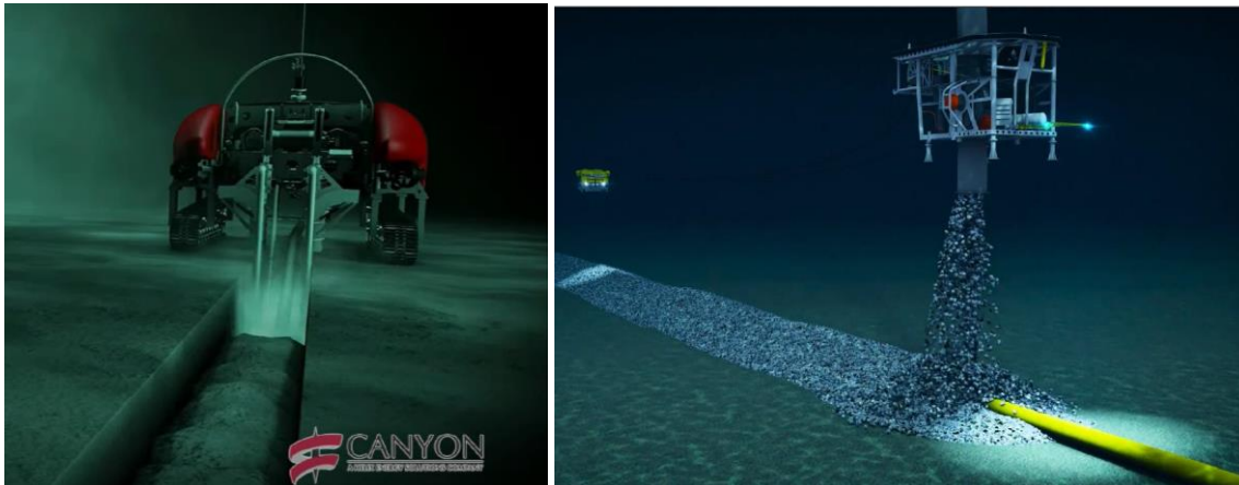
Figur 27 Typisk grøfteprofil til venstre og eksempel på grusstreng på eksponert rørledning til høyre. Kilde: notat «vurdering av høringsuttalelser fra Fiskarlaget Vest og Fiskeridirektoratet» av 11. mars 2022
