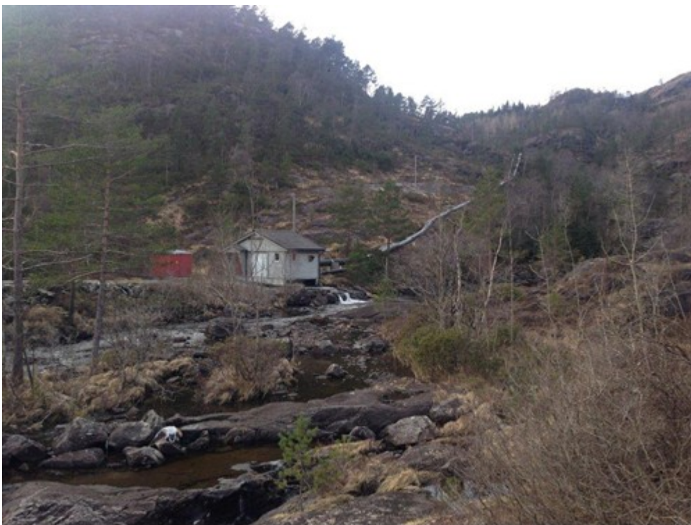
Kraftkameratene sitt kraftverk ved Grasdalen. Foto: E. Sofienlund
