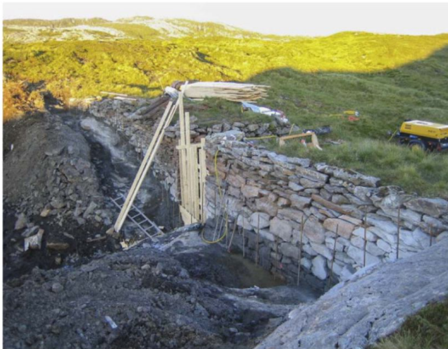
ALLEREDE UTBYGD: Vassdraget der det har oppstått strid om nytt kraftverk, det såkalte Boge 3, er allerede utbygd. Her fra utbedringen av demningen på Krosstjørnane i forbindelse med Boge 2. Her måtte Krosstjørnane tappes helt ned.
