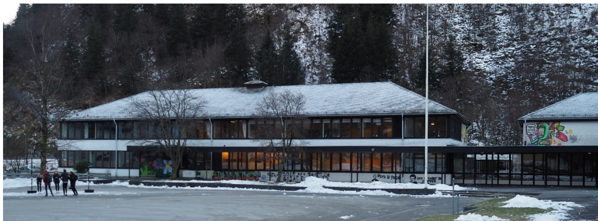
Bygg som skal rivast som følgje av ny barne- og ungdomsskule (foto Rambøll).
