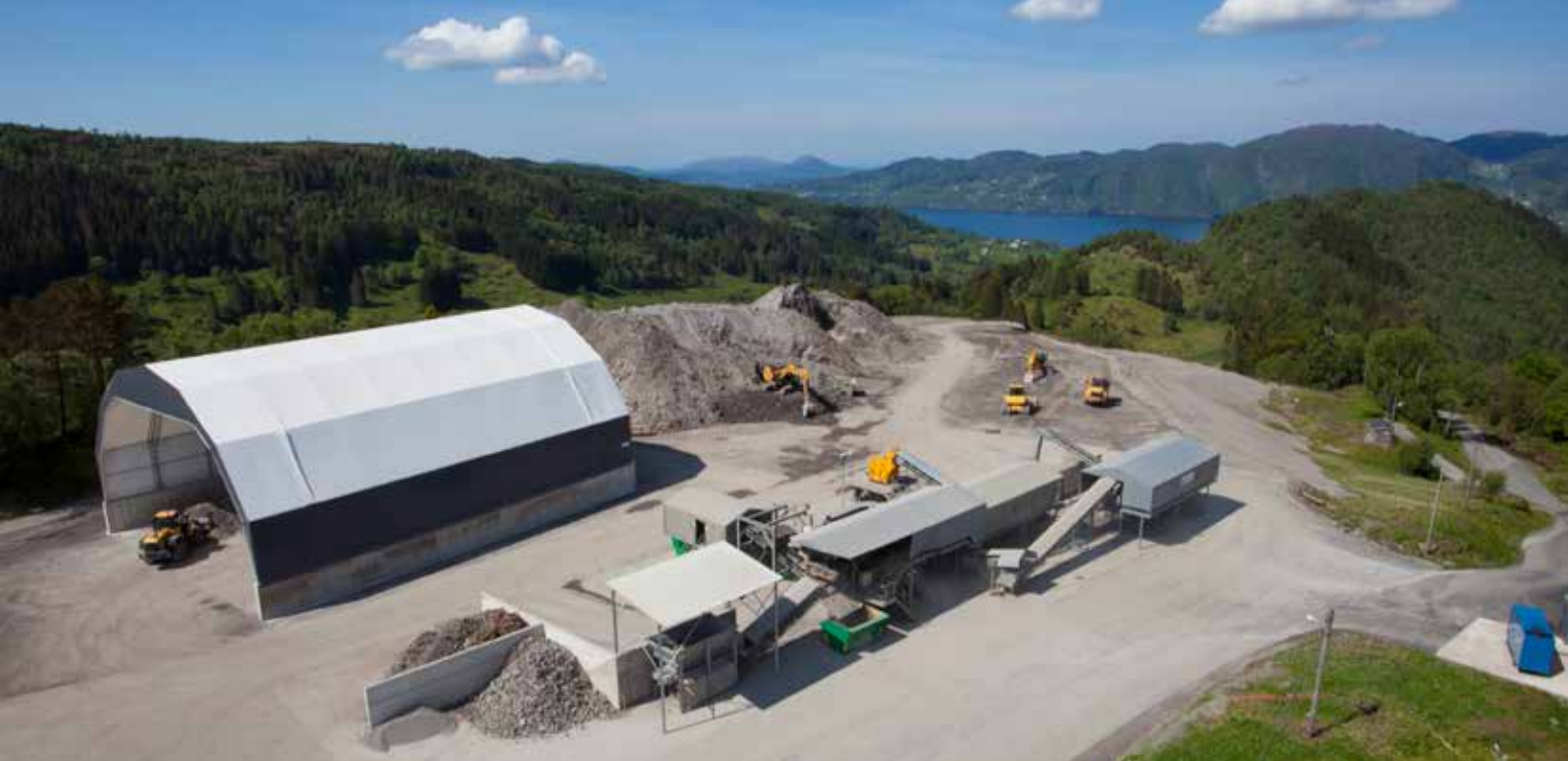
Slaggsorteringsanlegget på Mjelstad på Osterøy (2014).
