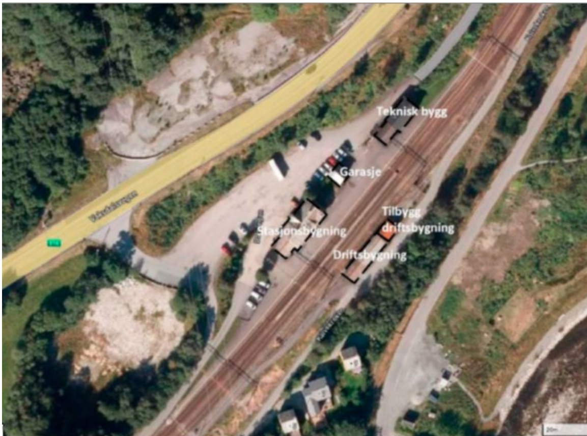
Figur 4; Bygningar på stasjonsområdet på Dale
