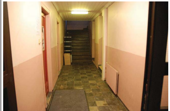
Bilde nr. 255.03 Gulvoverflater 1.etg. korridor mellom bibliotek og frisør. Opprinnelig skifer.
