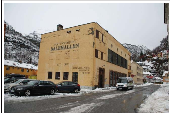
Bilde nr. 230.06 Yttervegger Fasade mot sør.
