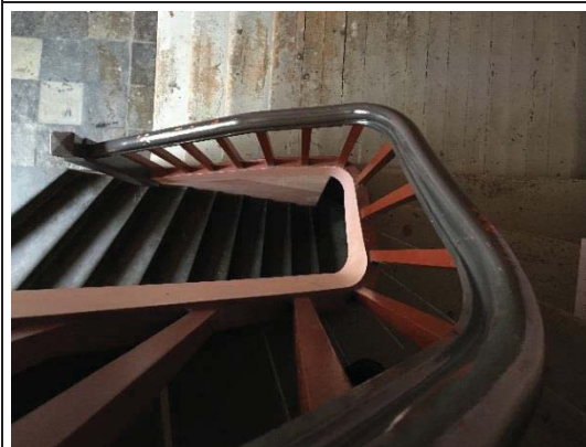
Bilde nr. 280. 06 Trapper, balkonger mm. Trapperom i sørvest bak scene.
