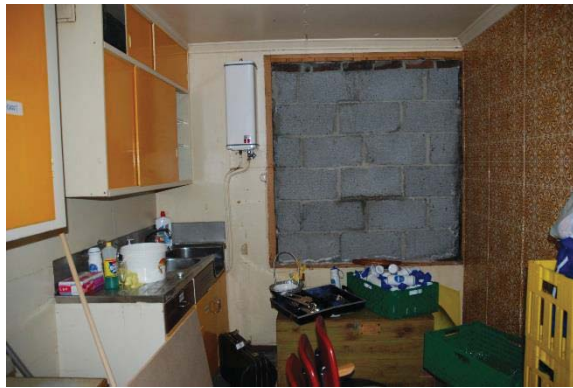
Bilde nr. 244.09 Innvendige vinduer, dører , foldevegger 3. etg. leilighet. Vinduer på fasade mot sør er blendet igjen med leca.
