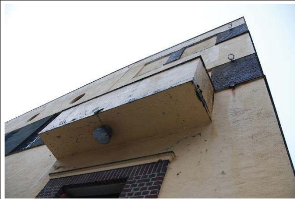
Bilde nr. 230.03 Yttervegger Detalj balkong og små sprang i fasaden.
