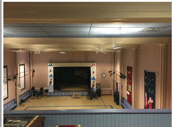
Bilde nr. 256.02 Himlinger 2. etg. Festsal. Opprinnelig himling, malt i ny farge.
