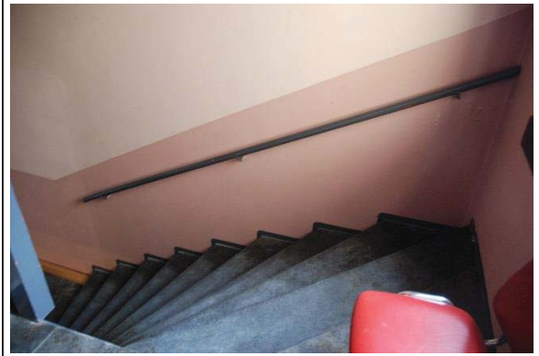
Bilde nr. 255.07 Gulvoverflater Linoleum på trinn. Usikker på dato.
