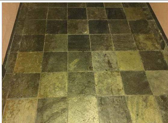
Bilde nr. 255.04 Gulvoverflater 1.etg. korridor mellom bibliotek og frisør. Opprinnelig skifer.
