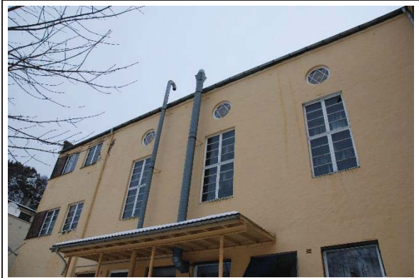
Bilde nr. 234.02 Utvendige vinduer, dører, porter Vinduer i 2. og 3. etg på fasade mot vest er opprinnelige. fra 1937. Farge og materialbruk er inntakt.
