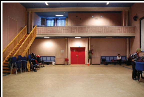
Bilde nr. 280. 04 Trapper, balkonger mm. 2. etg. festsal. Opprinnelig rekkverk på galleri. Trapp i furu er av nyere dato.
