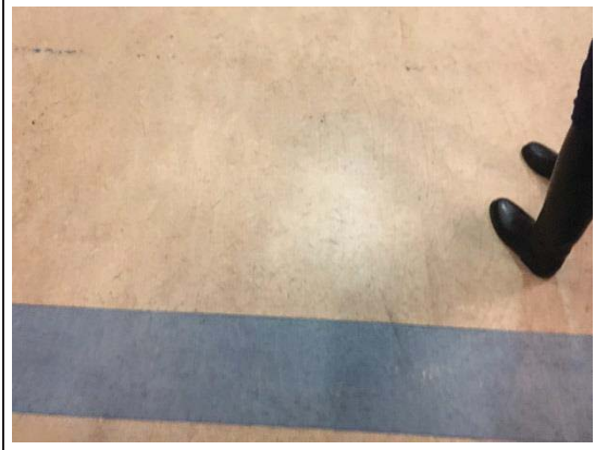
Bilde nr. 255.09 Gulvoverflater Gulv i festsal. Linoleum, sannsynligvis av nyere opprinnelse.
