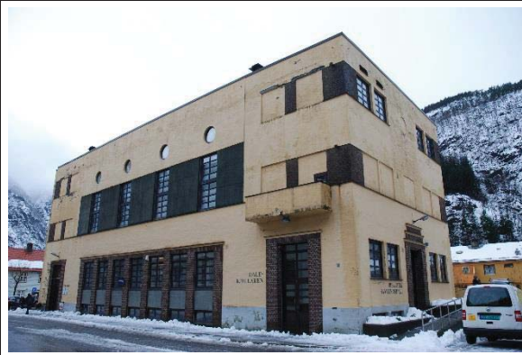
Bilde nr. 230.01 Yttervegger Fasade mot vest.
