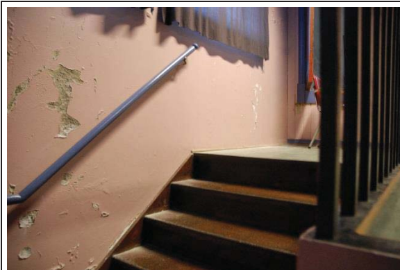
Bilde nr. 240.02 Innervegger Opprinnelige glattpussede vegger.
