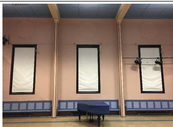
Bilde nr. 244.05 Innvendige vinduer, dører , foldevegger 2. etg festsal. Vinduer på fasade mot vest er blendet igjen fra innsiden, men er originale bak forblendingen. Pilastre er fra opprinnelig byggeår. Farger er sannsynligvis ikke opprinnelig.
