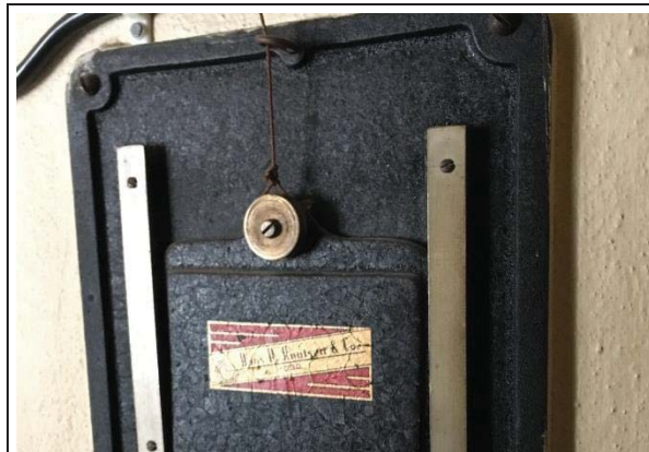
Bilde nr. 270.04 Fast inventar. Inspeksjonsluge i vegg mot festsal til visning av spillefilm.
