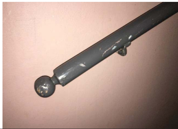
Bilde nr. 280. 09 Trapper, balkonger mm. Opprinnelig håndløper i trapp sørvest.
