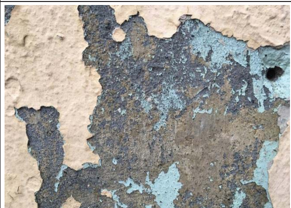
Bilde nr. 230.05 Yttervegger Detalj. Malingsflass viser at bygget kan ha hatt en annen farge opprinnelig.
