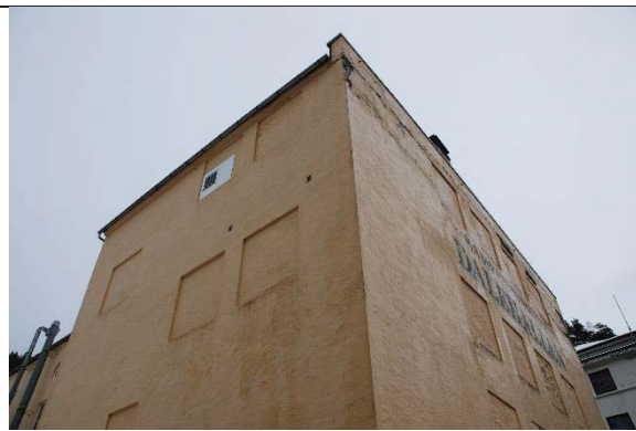
Bilde nr. 234.05 Utvendige vinduer, dører, porter Vinduer blendet igjen.
