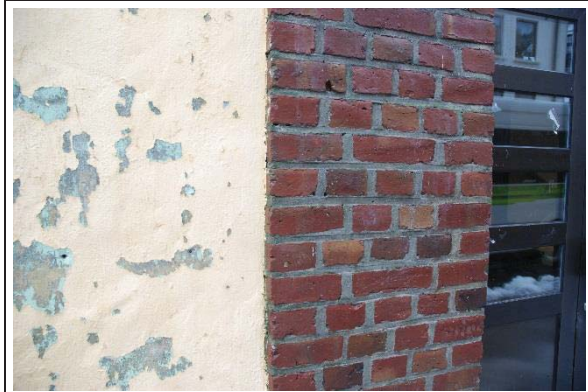
Bilde nr. 230.04 Yttervegger Malingsflass viser at bygget kan ha hatt en annen farge opprinnelig.
