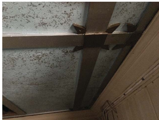
Bilde nr. 256.03 Himlinger Himling i trapp til filmfremviserrom. Denne himlingen har original maling. Denne har svært stor kulturhistorisk verdi. Festsalen har sansynligvis hatt samme type farge.
