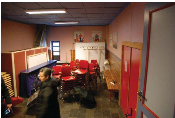
Bilde nr. 256.01 Himlinger. Opprinnelig himling, malt i ny farge.
