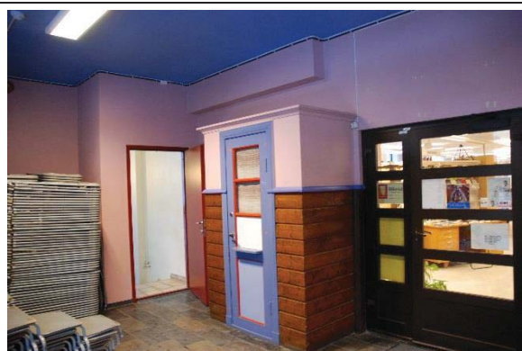
Bilde nr. 240.03 Innervegger Brystningspanel i foaje 1. og 2. etg viser på arkitektens tegning fra 1937. Dagens panel er sannsynligvis erstatning for opprinnelig panel.
