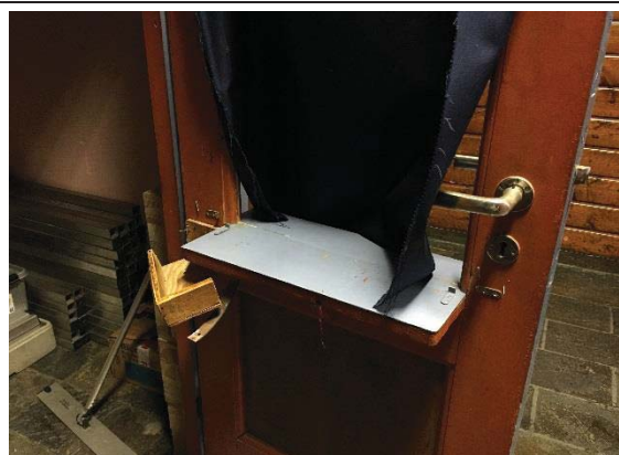
Bilde nr. 244.03 Innvendige vinduer, dører , foldevegger Dør med luke til billett kiosk i foaje 2. etg.
