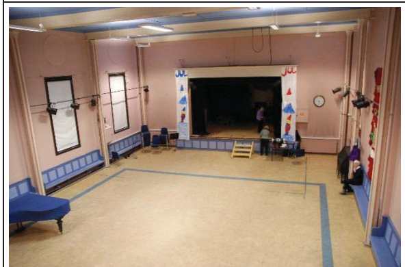
Bilde nr. 290 02 Andre bygningsdeler 2. etg festsal. Pilastre er fra opprinnelig byggeår. Farger er sannsynligvis ikke opprinnelig.
