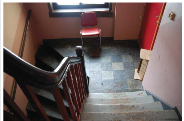
Bilde nr. 255.05 Gulvoverflater Opprinnelig skifer på gulv. Malt tre trapp.
