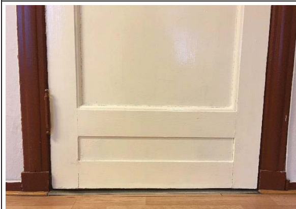
Bilde nr. 244.08 Innvendige vinduer, dører , foldevegger 1. etg korridor mellom bibliotek og frisør. Opprinnelig dør i korridor.
