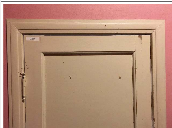
Bilde nr. 244.06 Innvendige vinduer, dører , foldevegger 2. etg rom bak scene. Opprinnelig dør med listverk, hengsler og dørklinke.
