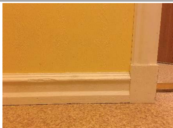
Bilde nr. 23. 1. etg. Eksempel på opprinnelig gulvlist.
