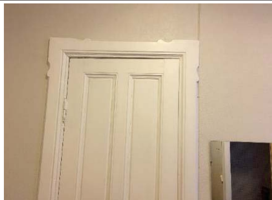
Bilde nr. 35 2. etg rom 23: opprinnelig dør, listverk og hengsler.
