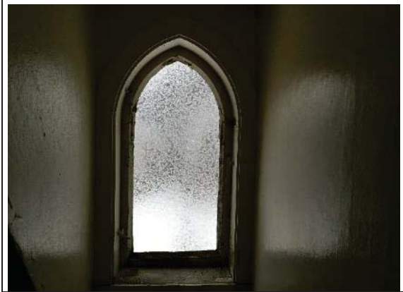
Bilde nr. 38 3. etg legekontor. Vindu fra opprinnelig byggeår.
