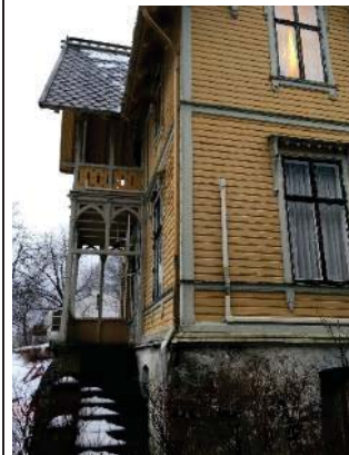
Bilde nr. 10. Sideinngang m.trapp opp til veranda.
