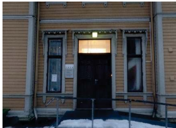
Bilde nr. 9. Inngang m. rampe. Speildør i tre med glassfelt over. Ny rampe m. rekkverk.
