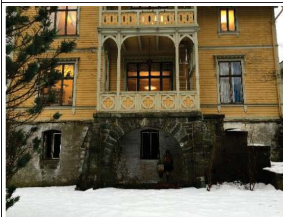
Bilde nr. 6. Kjellerinngang.
