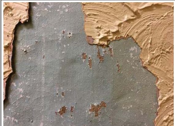
Bilde nr. 18. 1.etg gang: opprinnelig tapet under nyere malingslag.
