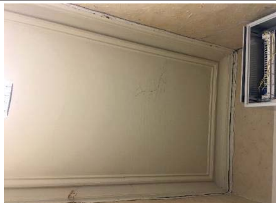
Bilde nr. 17. 1.etg. gang. Opprinnelig himling og listverk.
