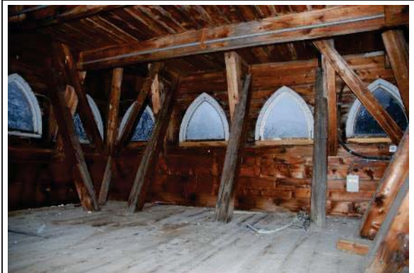
Bilde nr. 42 Tårnrom. Ubehandlede overflater, opprinnelige bygningsdeler.
