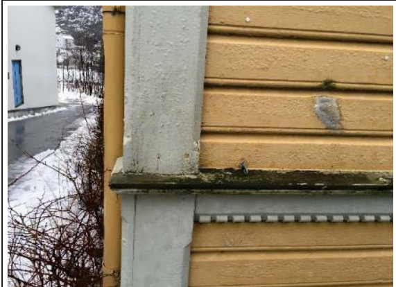
Bilde nr. 8. Liggende staffpanel. Hjørnekasser og dekorative bånd i kontrasterende farge.
