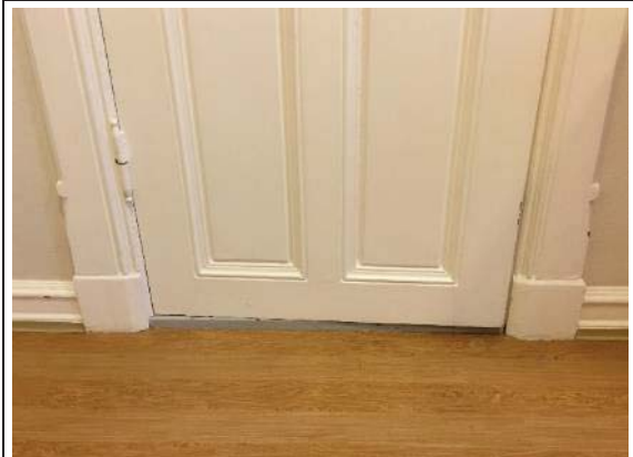
Bilde nr. 36 2. etg rom 23: opprinnelig dør, listverk og hengsler, listverk på gulv.
