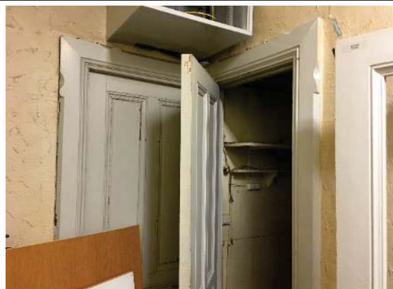
Bilde nr. 19. 1. etg gang. Opprinnelige dører med listverk .
