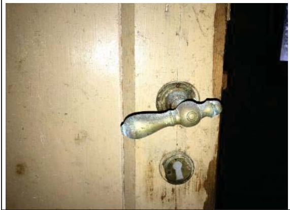
Bilde nr. 14. Original dørvrider. Kjellerdør.
