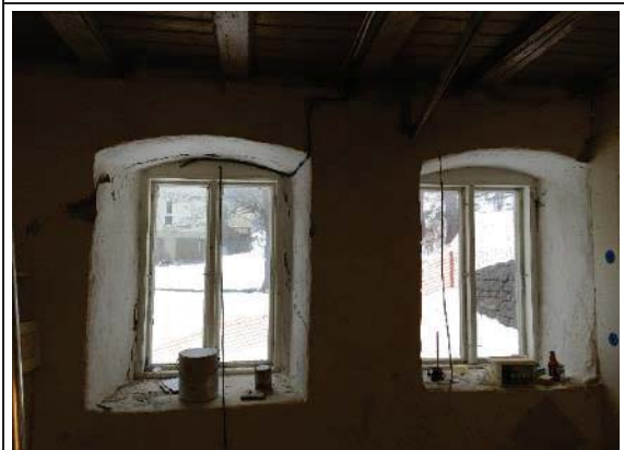
Bilde nr. 12. Kjellervinduer i murte vindusnisjer. Vinduer er originale fra byggeår.
