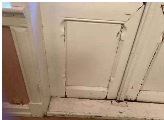
Bilde nr. 21. 1. etg rom i tilknytning til glassveranda Opprinnelig dør og vinduer.
