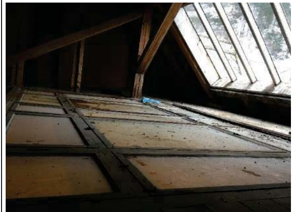
Bilde nr. 40 Takvindu, og overlysvindu over tarpperom.
