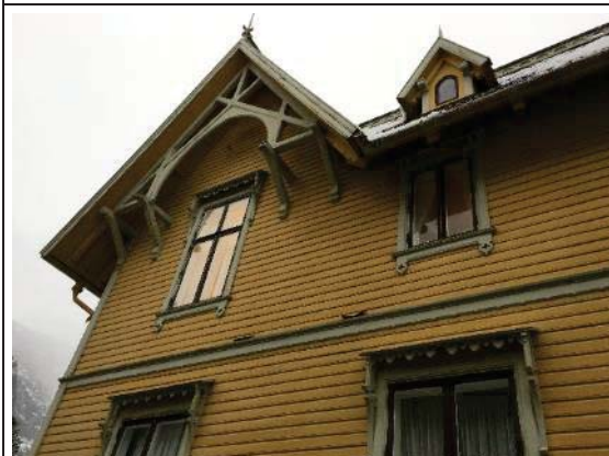
Bilde nr. 4. Fasadedetalj. Listverk og vannbrett over vindu.
