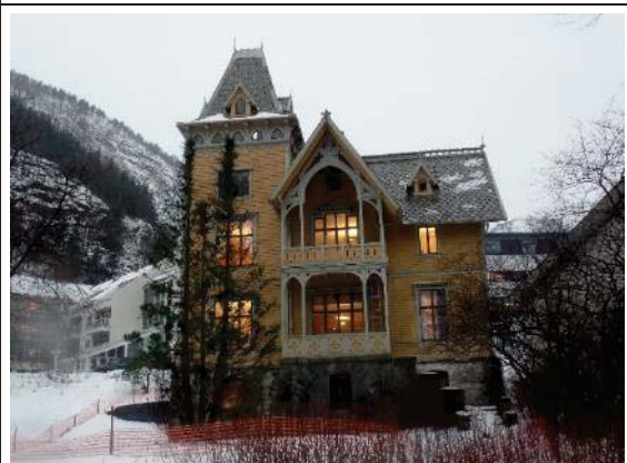
Bilde nr. 3. Fasade mot øst.
