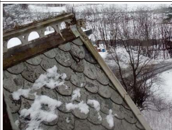
Bilde nr. 5. Skifertak. Dråpeskifer fra opprinnelig byggeår.
