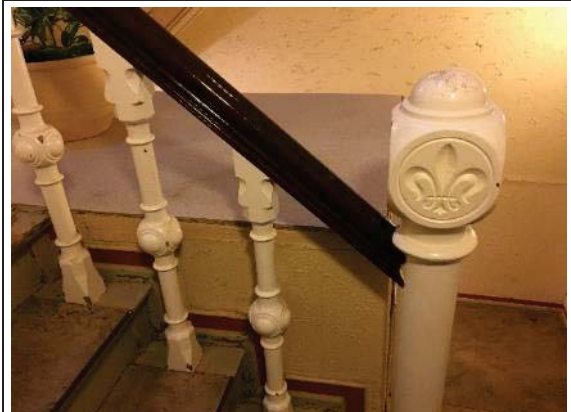
Bilde nr. 30. Dekoret trappestolpe, og rekkeverk i trapp.
