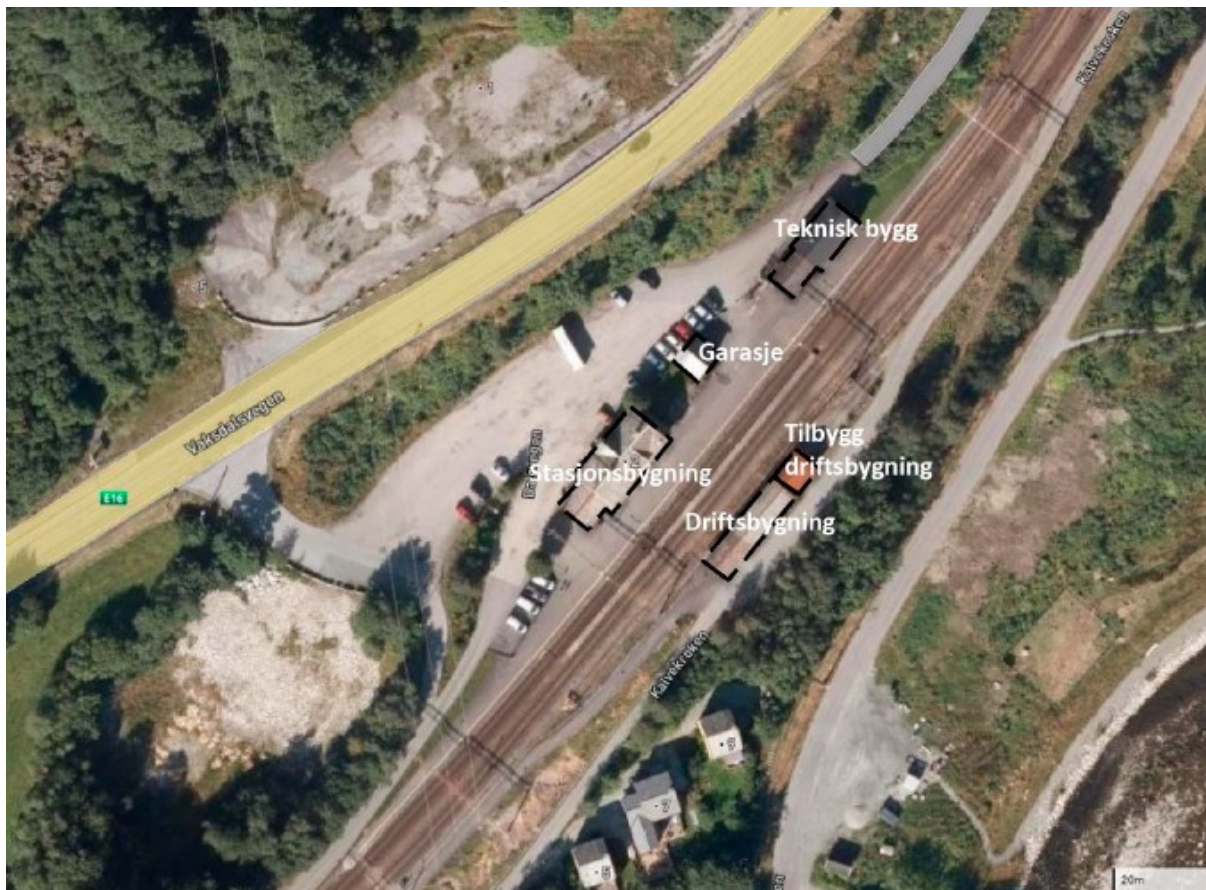
Figur 4; Bygninger på stasjonsområdet på Dale
