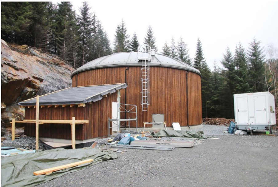
Nytt kommunalt vassverk opna på Vaksdal i 2020
