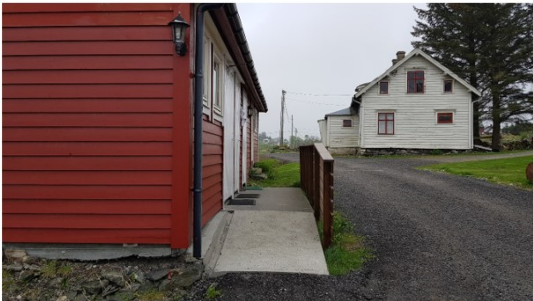
Gangvei ved sanitærbygg, laget gjerde mot veg.
