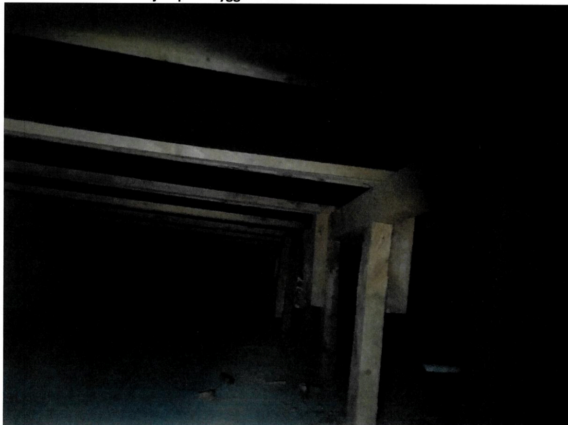
Bilde 4: Svikt i konstruksjon på tilbygg frå 1975
