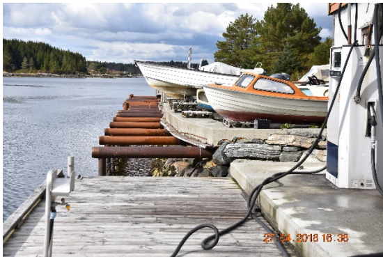
Drivstoffpume ytterst på kai. Det er på de utstikkene stålrør, at det planlegges å lage en kaifront i tre, samt også kaidekke i trevirke.
