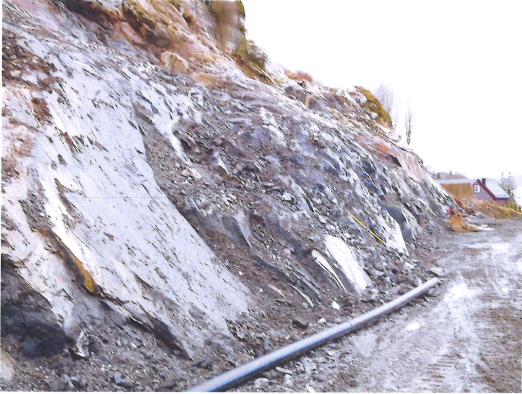
Fig.5: Ferdig rensk. Fjellet står der med sitt naturlige fall. Ingen avskårne flater.
