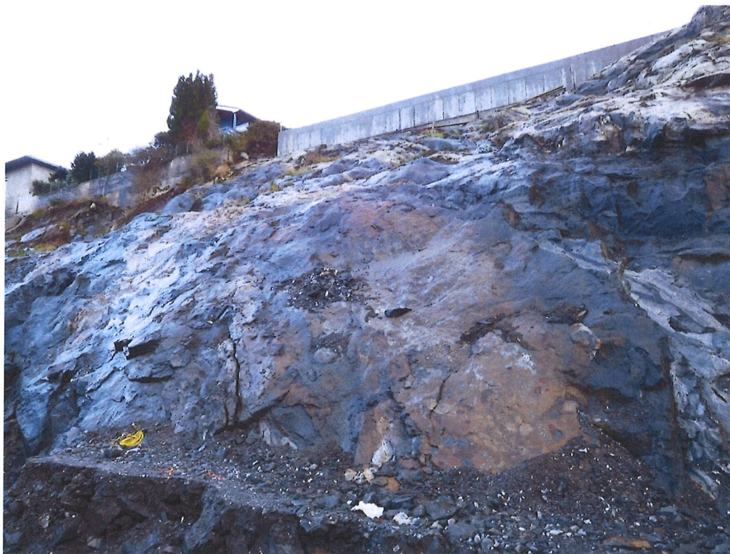
Fig.9: Nordlige del av fjelloverflaten. I toppen ser vi det er satt opp en ny mur, denne gang i betong inn mot naboeiendommen. Betongmuren er armert og forankret i fjell. Arbeidet ser ut til å være utført på en betryggende måte. Fjellet er her en mørk amfibolitt.
