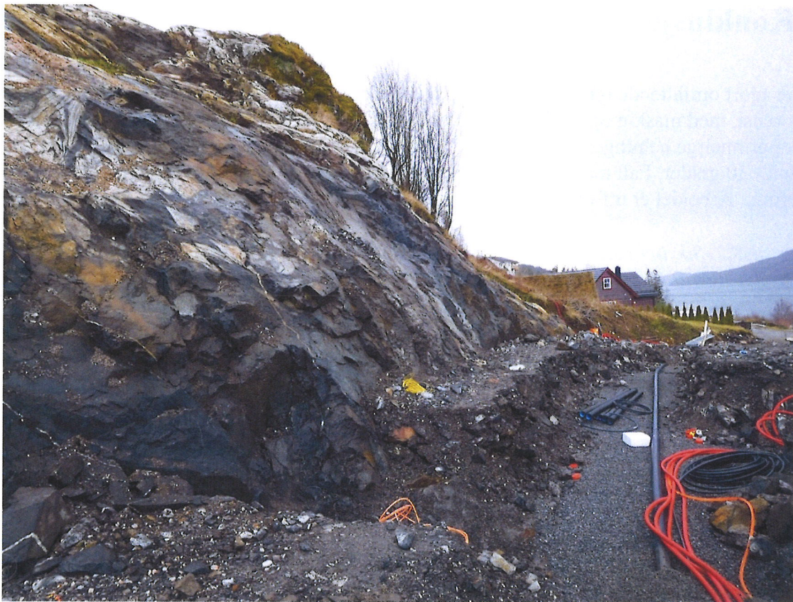
Fig.8: Nordlige del av fjelloverflaten. Her er det en mørk bergart, trolig en amfibolitt.
