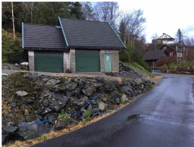
Foto fra Ørnnova/vest, mot garasjer og avkjørsel
