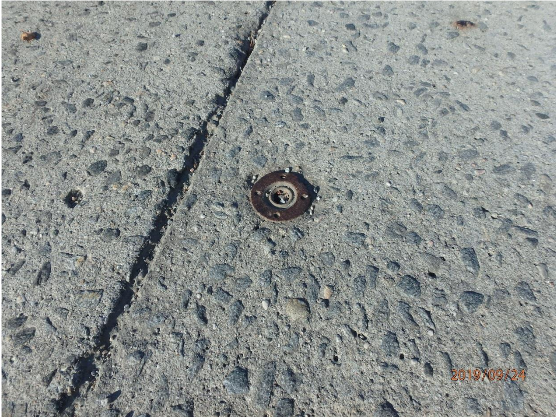
Bilde nr. 7 Lett overflateslitasje i brudekke.
