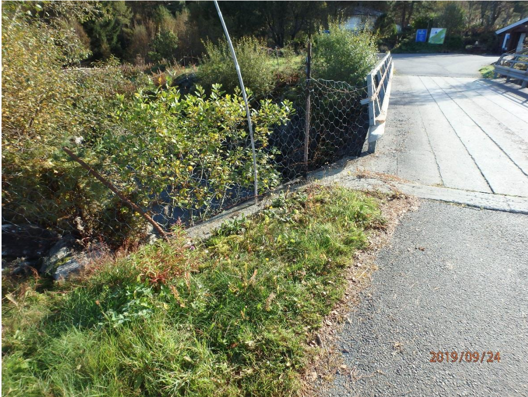
Bilde nr. 3 Rekkverksovergang vestre landkar nordside.
