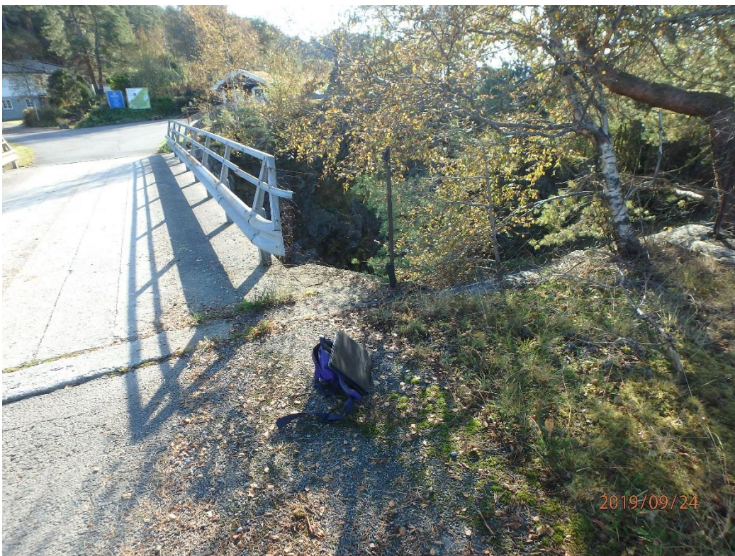
Bilde nr. 4 Rekkverksovergang vestre landkar sørside.
