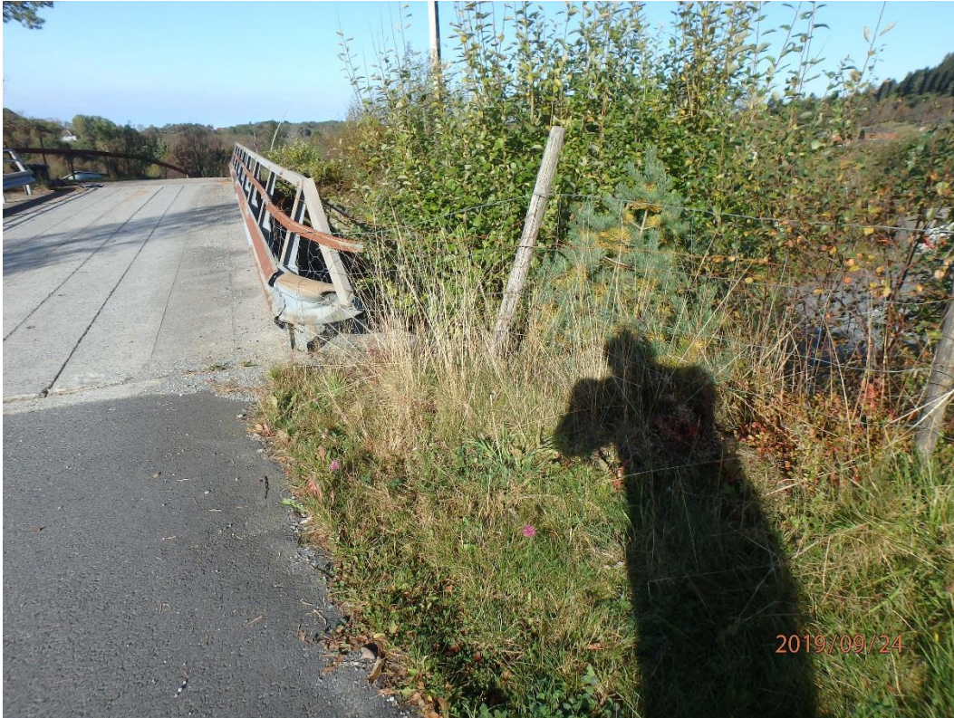
Bilde nr. 5 Rekkverksovergang østre landkar nordside.
