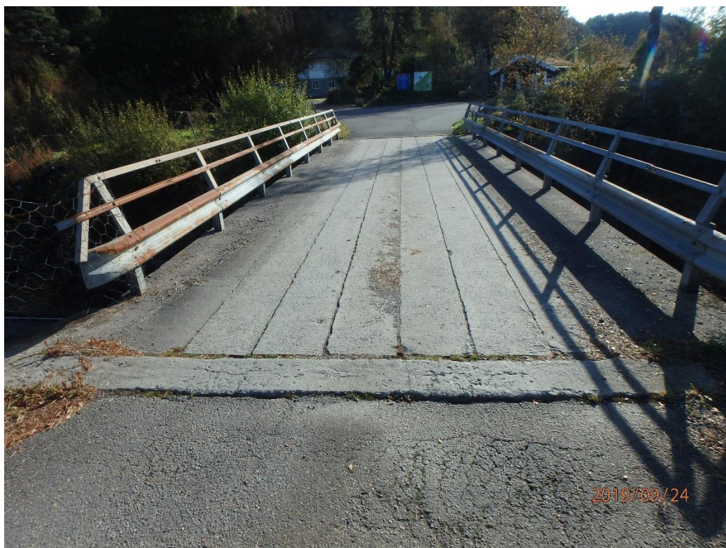
Bilde nr.1 Brudekke sett mot øst.
