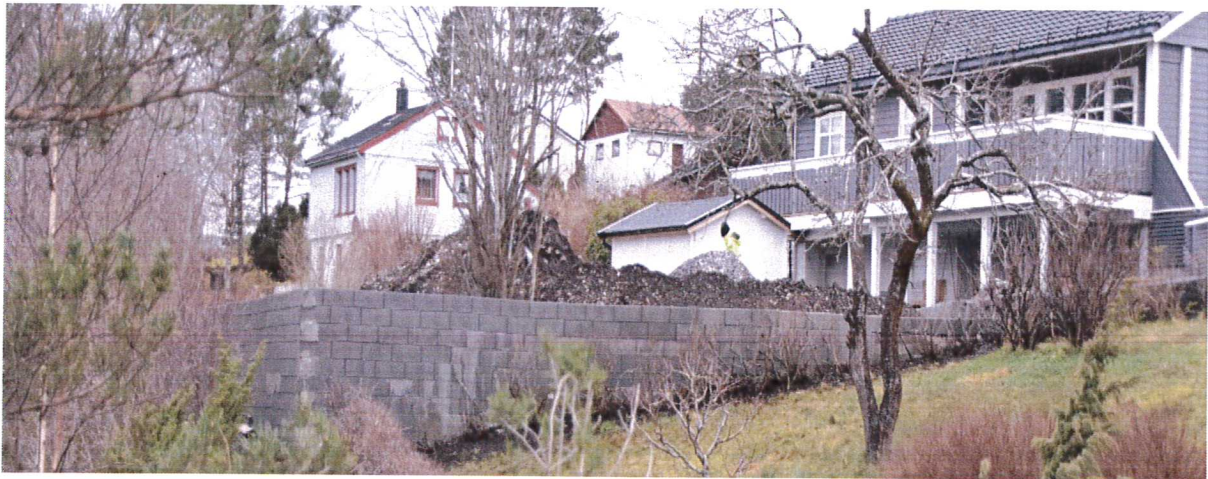
Forstøtningsmur, mot SØR-ØST
