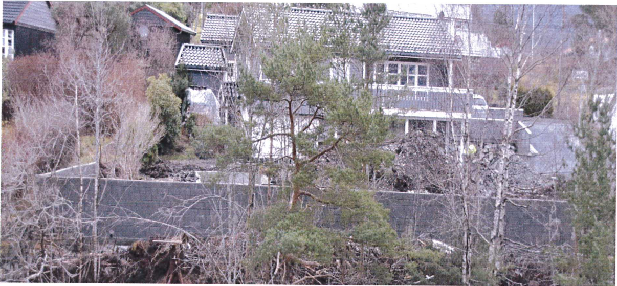
Forstøtningsmur , mot Fylkesvegen 392 ( mot SV )
