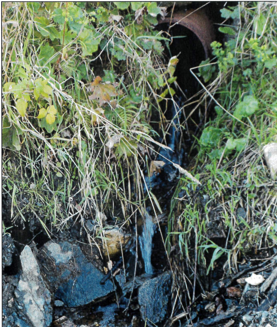
Figur 5-2. Nåværende dreneringsrør under vegen mot Li.
