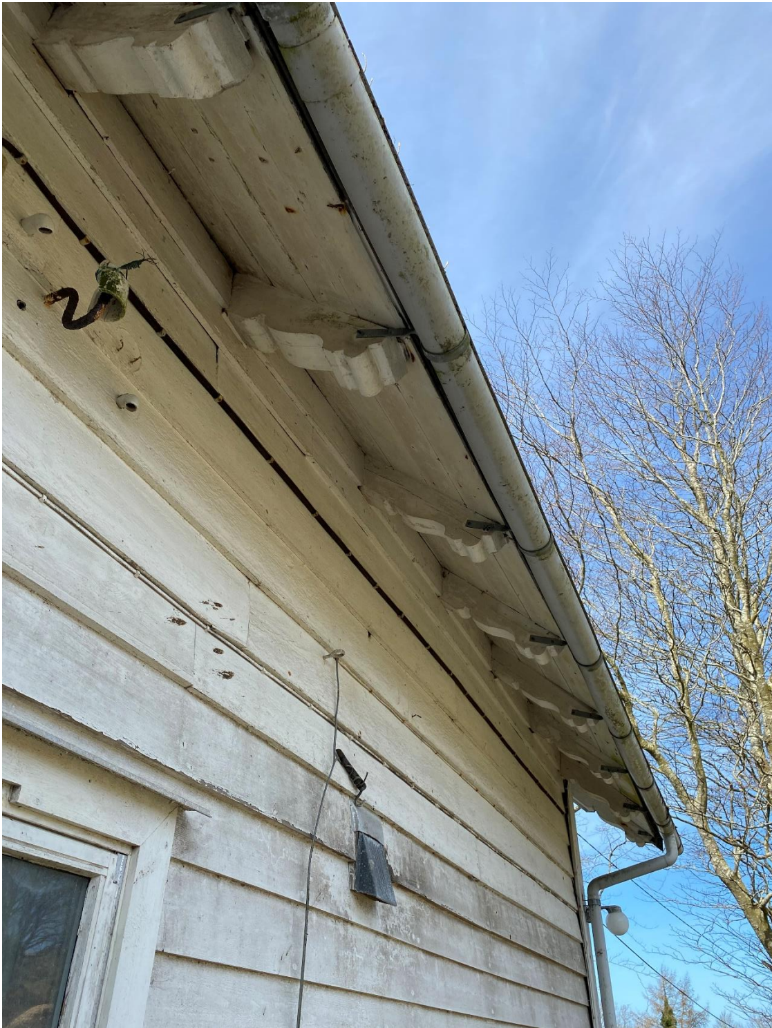
5 Utskorne sperrenderar og original kledning under rafta i aust
