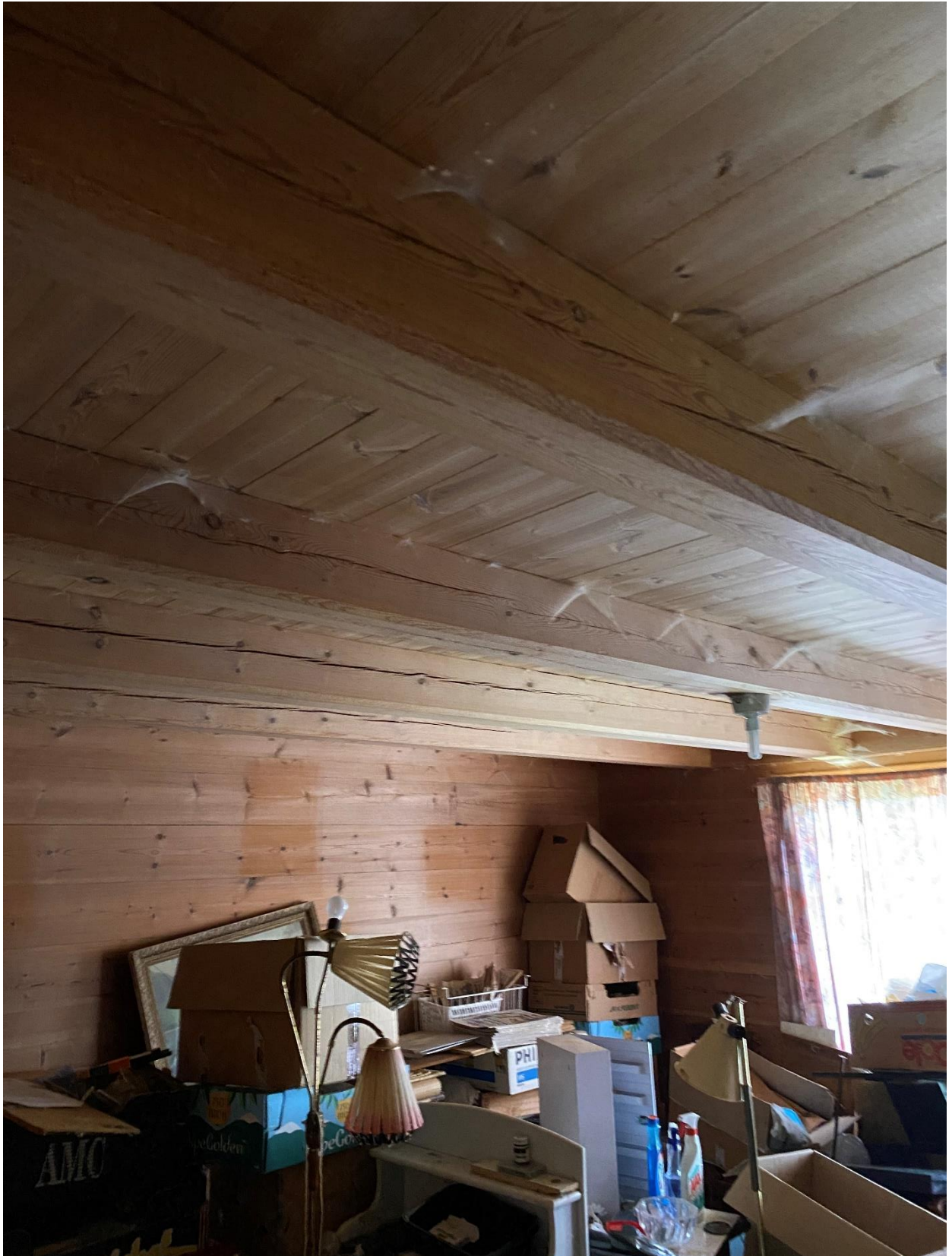
9 Søre stova er einaste staden vegg og bjelkelag er synleg. Det er denne delen av huset som ser ut til å vere i best stand.
