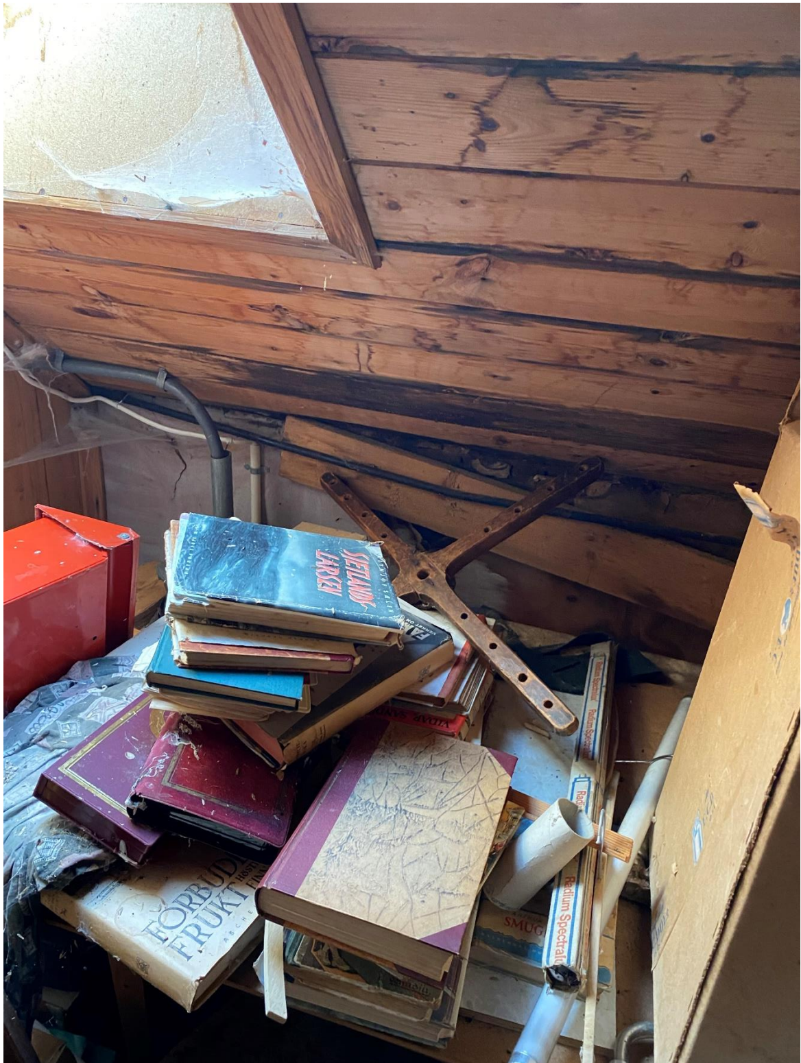
8 Leksje kring takvindu mot aust.
