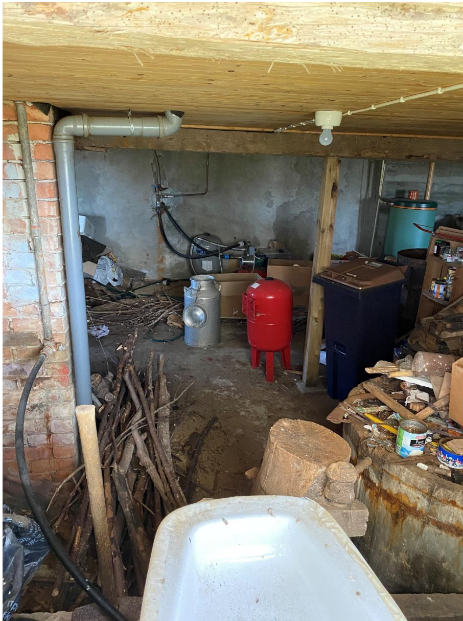
11Det er kjellar under heile huset. Denne ser ut til å vere tørr og fin.
