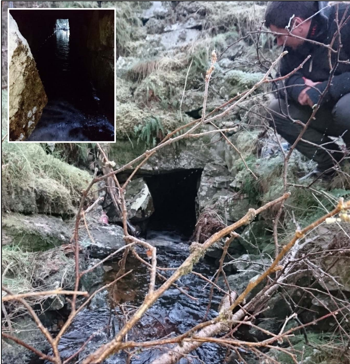
Figur 12 Kulverten (ca. 1 x 1 meter) i eksisterande fylkesveg ca. profilnr. 1800 (Snekkevika), blir her studert av vilforvaltar Andreas Granli i Radøy kommune. Det er viktig for fisken at det blir parti med open bekk. Innfelt bilete oppe til høgre syner sjølve kulverten som går beint gjennom 90° på vegen. Foto: Magnar Bjerga, Statens vegvesen.
