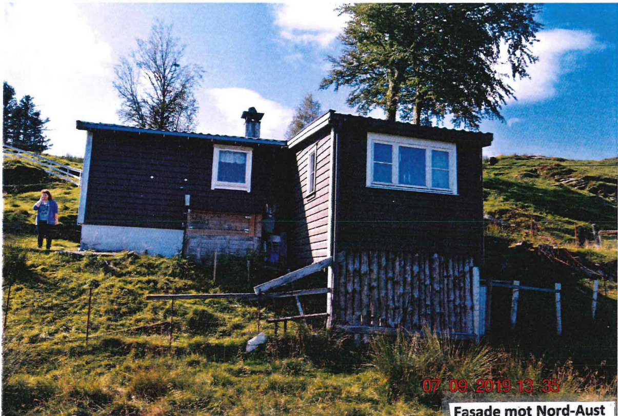
Fasade mot Nord-Aust
