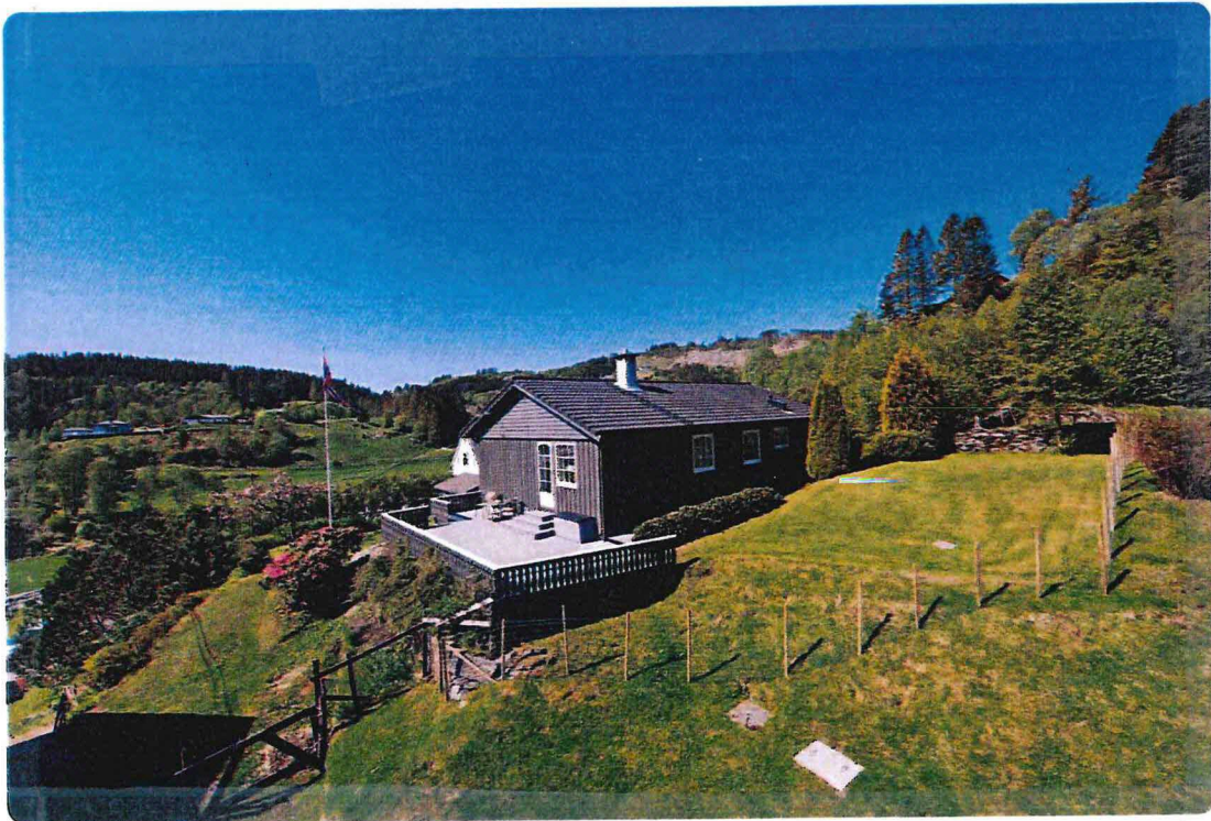
Foto av nåværende situasjon Langside mot Nord-Øst, Gavlfasade mot Syd-Øst
