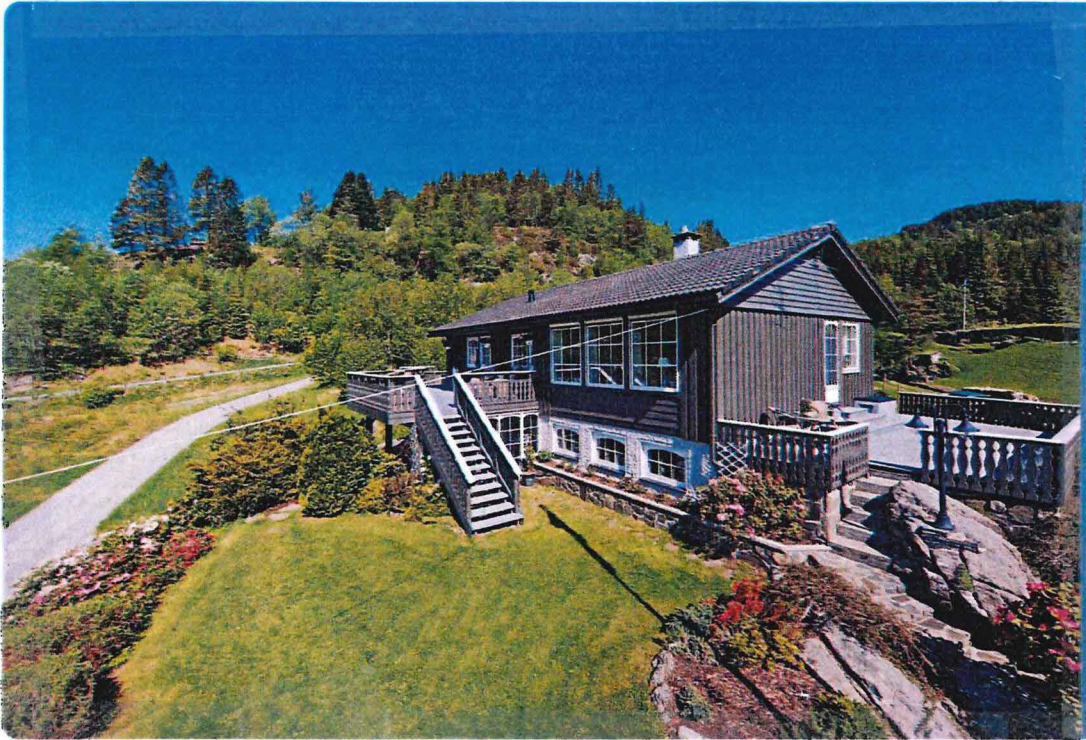
Foto av nåværende situasjon Langside mot Syd-Vest , Gavlfasade mot Syd-Øst
