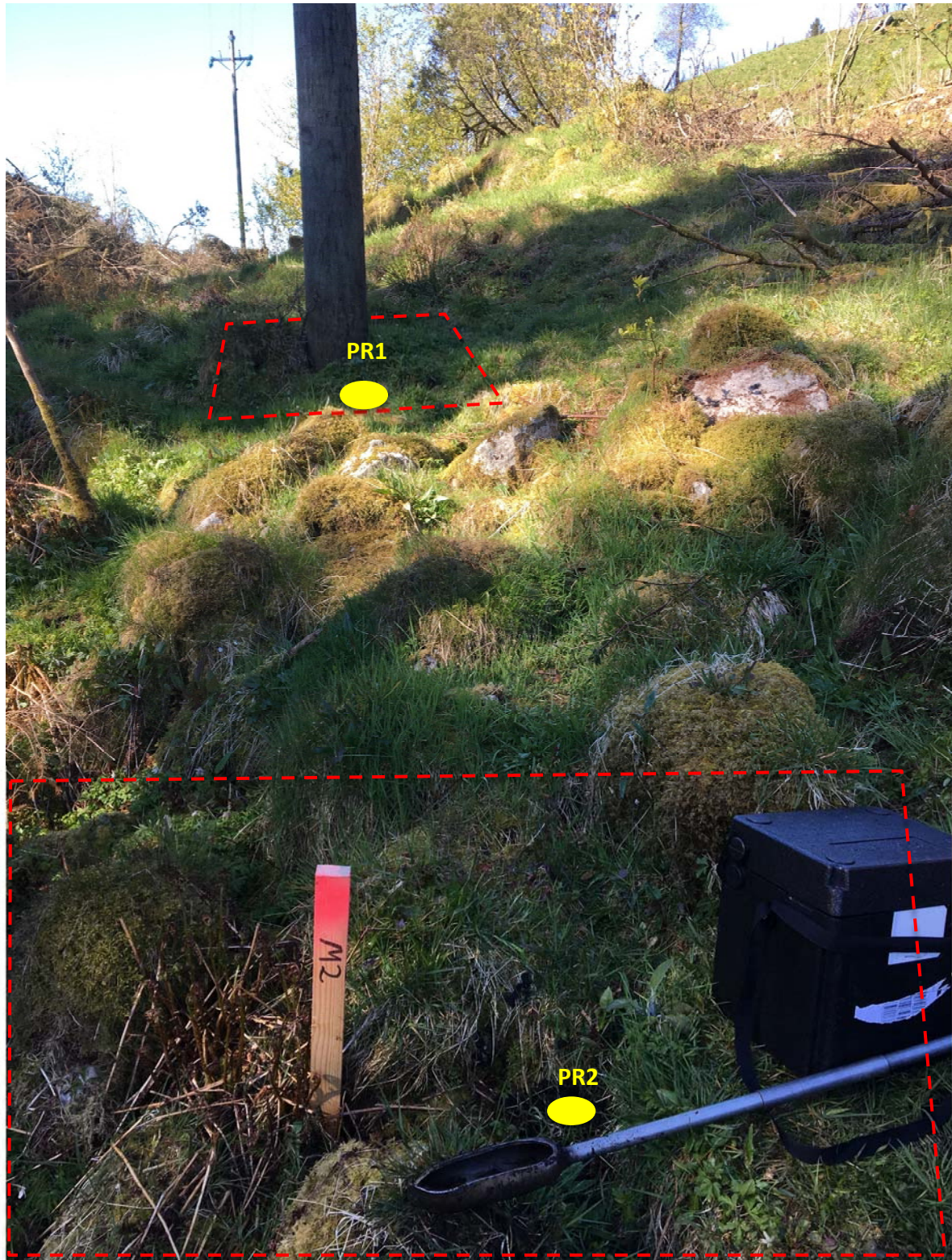
Figur 4-2: Bildet viser stolpen som skal skiftes, samt lokalitet for planlagt ny mast. Omtrentlige områder hvor det skal graves er markert med stiplede røde linjer. Gule sirkler viser hvor jordprøvene er tatt. Bildet er tatt mot sørvest. Foto: Multiconsult
