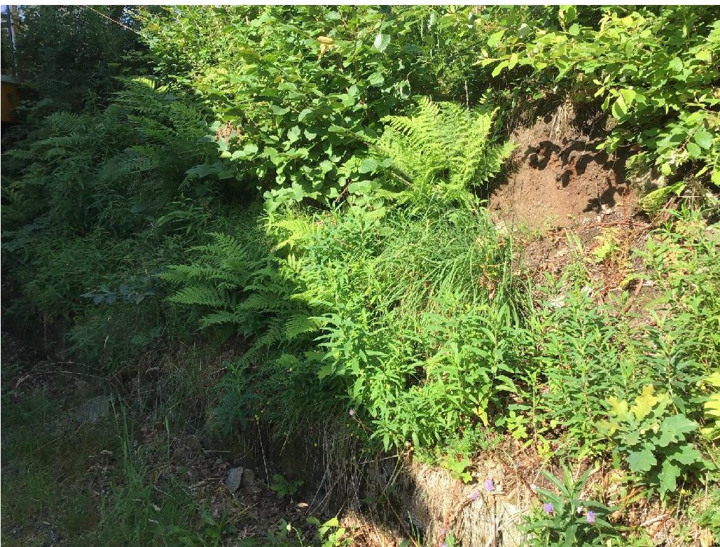
Figur 17. Naturleg skråning bak skulehuset. Litt erosjon i lausmassane.
