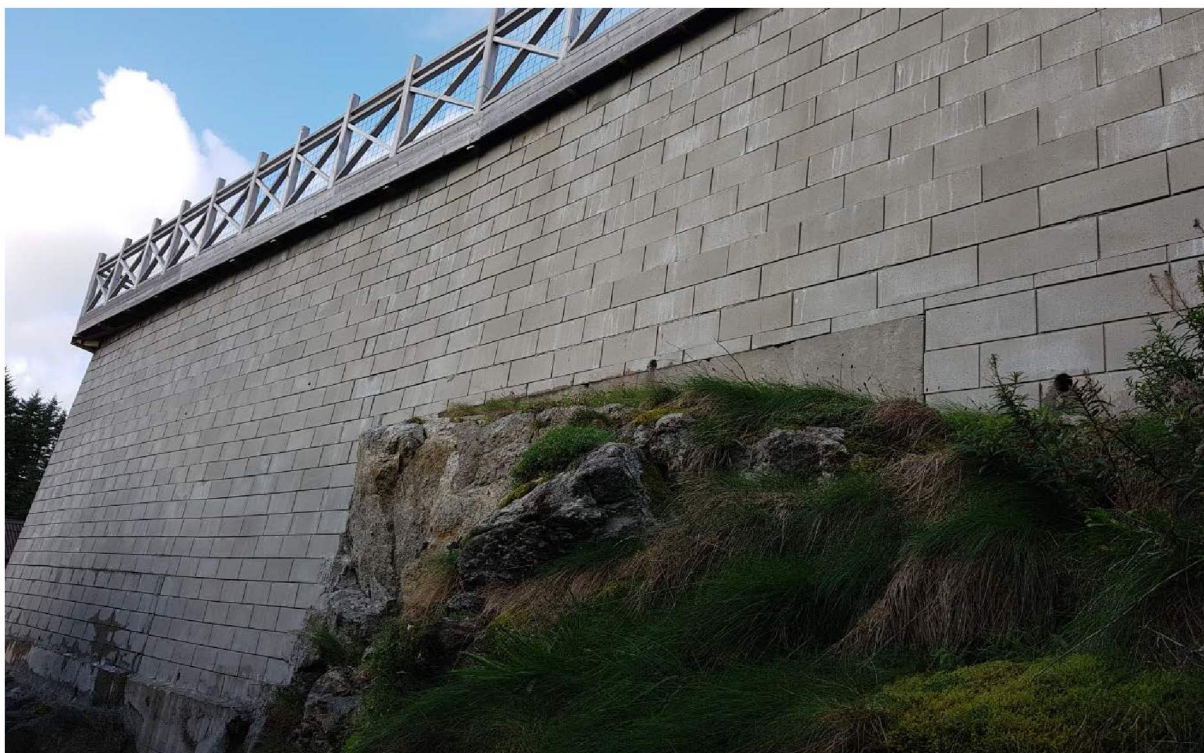
Mur i front mot vest med fjell i dagen mot naustrekke.
