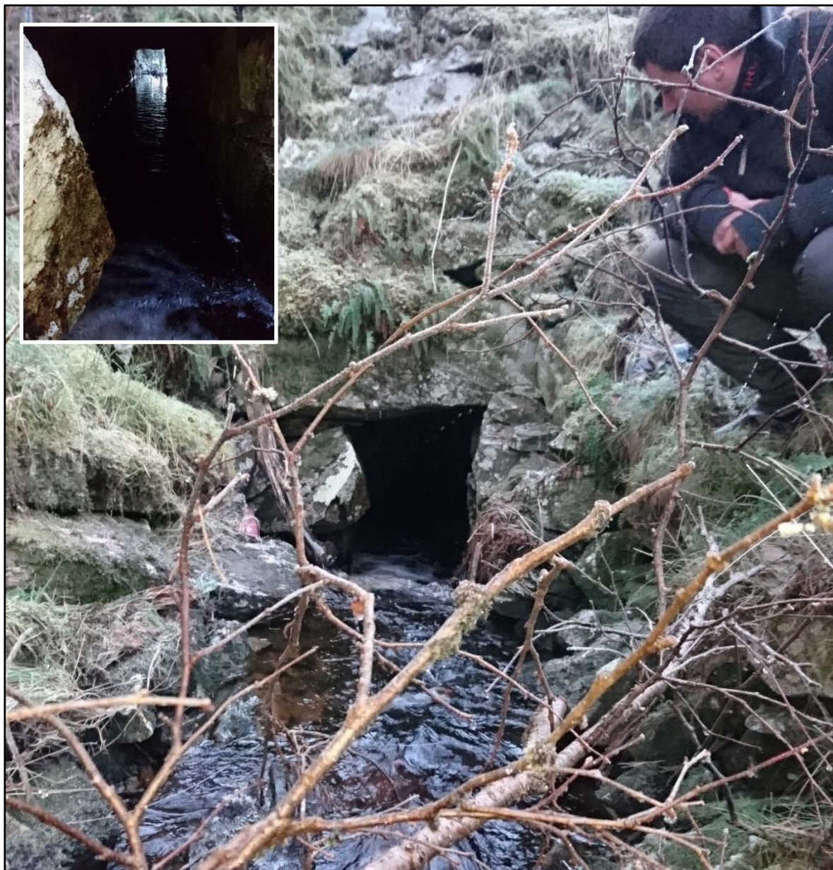
Figur 12 Kulverten (ca. 1 x 1 meter) i eksisterande fylkesveg ca. profilnr. 1800 (Snekkevika), blir her studert av vilforvaltar Andreas Granli i Radøy kommune. Det er viktig for fisken at det blir parti med open bekk. Innfelt bilete oppe til høgre syner sjølve kulverten som går beint gjennom 90° på vegen. Foto: Magnar Bjerga, Statens vegvesen.
