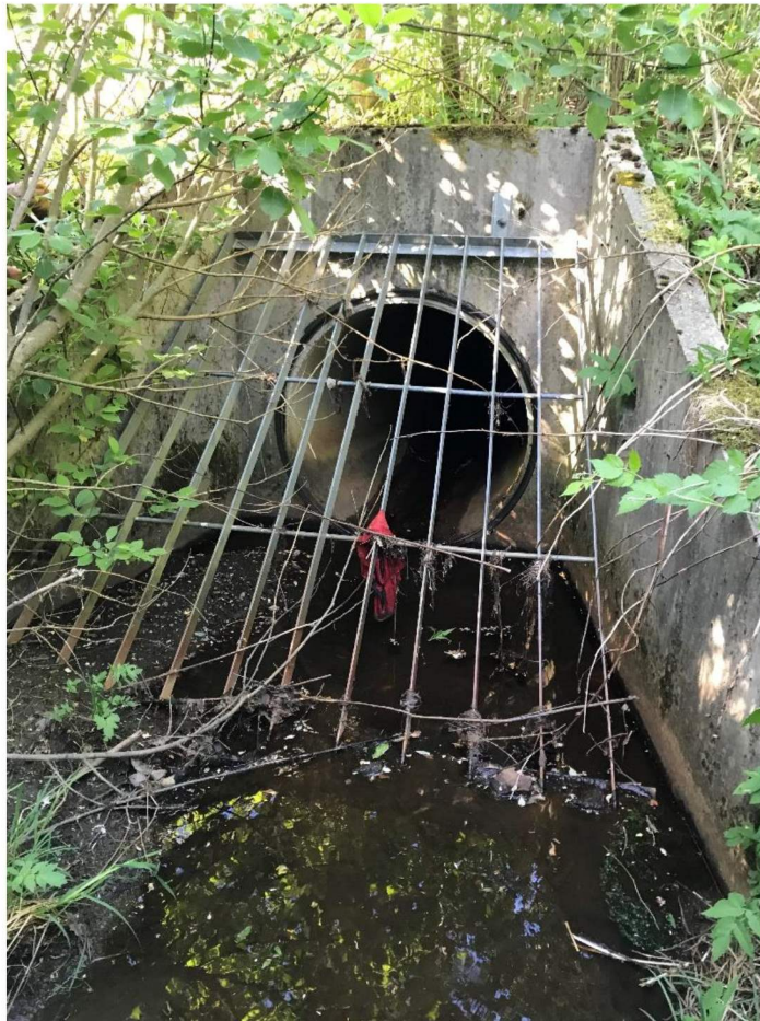
Bilde 1: Viser inntak til eksisterende DN1000-stikkrenne ved ca. profil 960 i Fv. 244.
